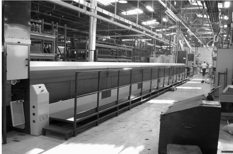
Bild 4.3: Heißluftvulkanisationsanlage (Foto: Fa. HSM GmbH)
