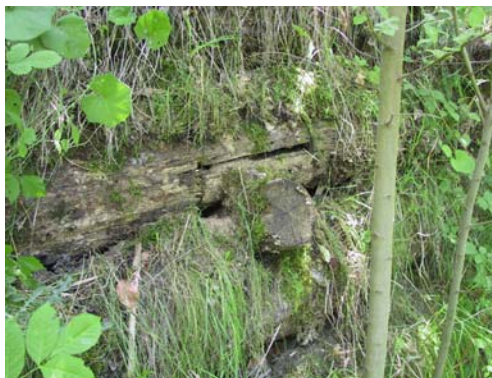
Abb. 179: Beispiel für keine Überlappung, das Längsholz hat sich unter dem Druck aufgespalten – Standort Tscheiner Krainerwand 01
