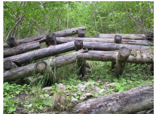
Abb. 75: Freigespülter Krainerwandkasten 03.1 (Sommer 2003) - Finsterbach
