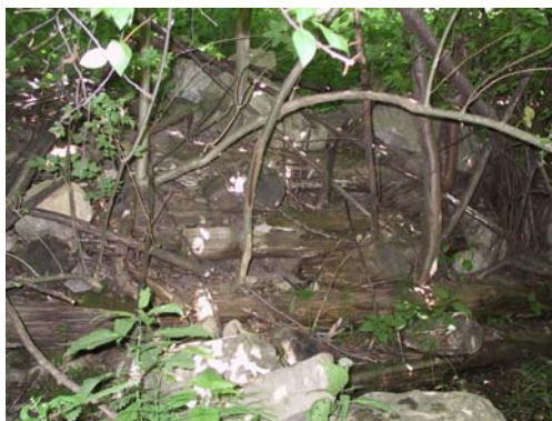
Abb. 91: Stark morsche Eisenbahnschwelle Farmahof Krainerwand 06
