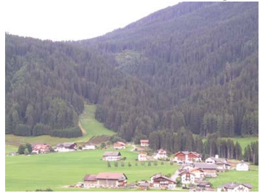
Abb. 87: Gegenhangaufnahme Finsterbach 2003 – die offenen Erosionsherde in der Mitte des Hanges sind erkennbar.
