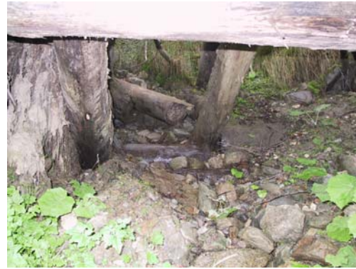
Abb. 85: Vollständig freigelegter Krainerwandkasten 03.1 - Finsterbach
