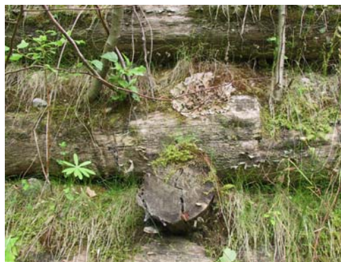
Abb. 181: Beispiel für gute Überlappung – Standort Mühlwald Krainerwand
