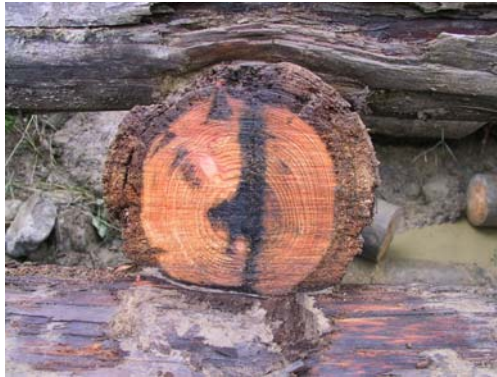
Abb. 176: Starke Holzfäule im Bereich der Metall-elemente (Finsterbach)
