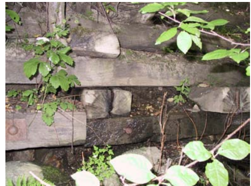
Abb. 107: Starke Wasseraustritte wurden im ganzen Hang beobachtet – Beispiel für schlechte Alternierung der Reihen Farmahof Krainerwand 07
