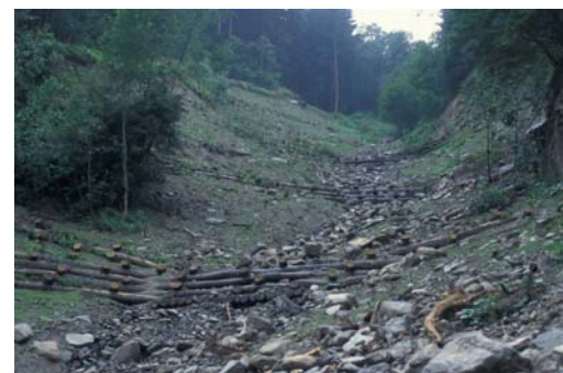
Abb. 46: Flügelsperrenbau im oberen Bereich des Kronengrabens (1997)
