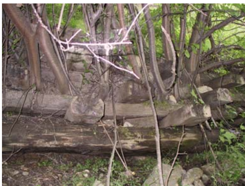
Abb. 92: Farmahof Krainerwand 05 aus Bahnschwellen und Lärchenrundhölzern
