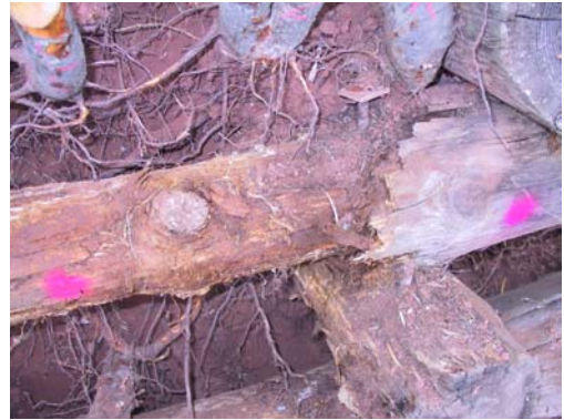
Abb. 175: Stark verminderte Holzqualität bei den äußeren Reihen – Standort Widmayer
