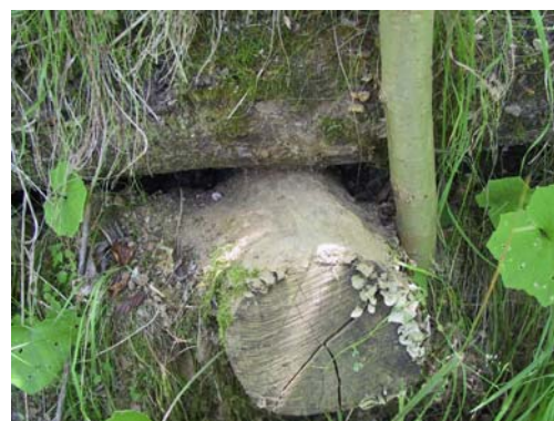
Abb. 5: Tscheiner Krainerwand 01 - Zange mit Nagel ohne Kopf
