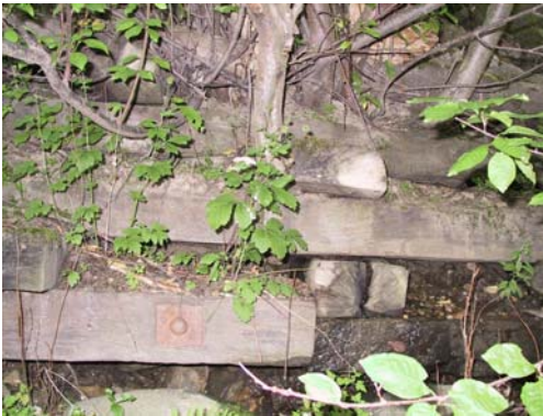
Abb. 182: Beispiel für schlechte Alternierung – Standort Farmahof Krainerwand 07
