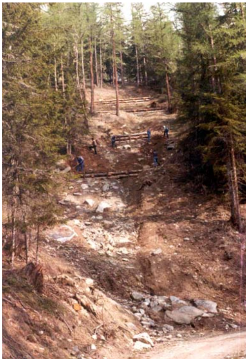
Abb. 108: Holzerlahn - Bau der Krainerwände 1985
