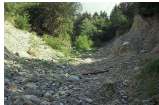
Abb. 45: Kronengraben vor der Sanierung 1995
