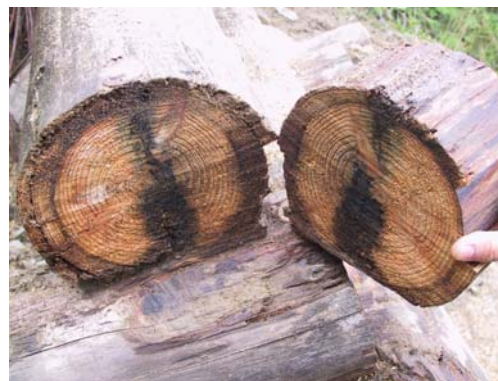
Abb. 178: Das Holz entlang des Nagelganges ist massiv angegriffen.
