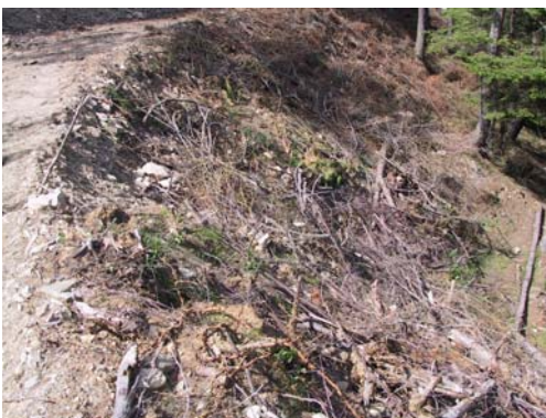
Abb. 119: Schnittmaßnahmen im Zuge der Forststraßenerneuerung
