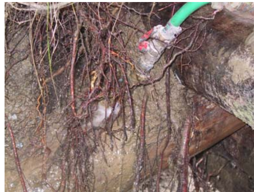
Abb. 2: Freispülen der Wurzelsysteme unter 2 bar Druck
