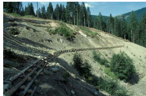
Abb. 74: Finsterbach Bau der Krainerwände 1992
