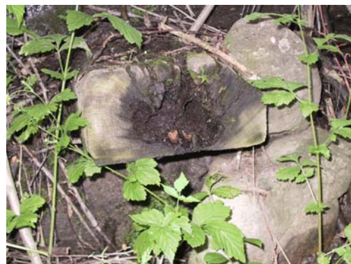
Abb. 91: Stark morsche Eisenbahnschwelle Farmahof Krainerwand 06
