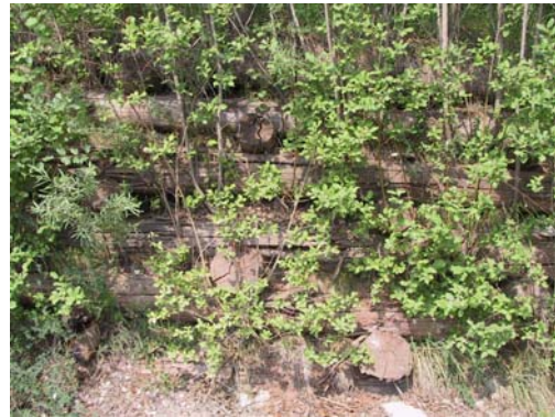
Abb. 183: Beispiel für gute Alternierung – Standort Widmayer Krainerwand 03
