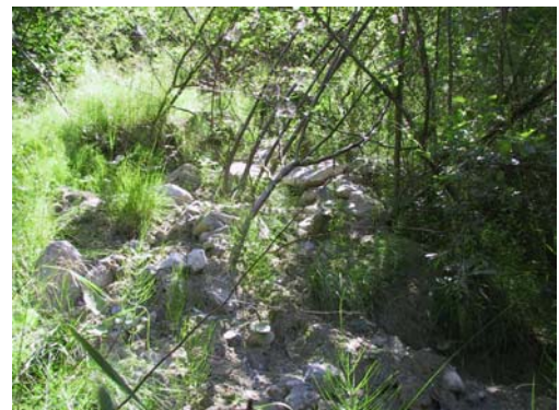
Abb. 55: Kronengraben - Überschotterung der Krainerwand 02
