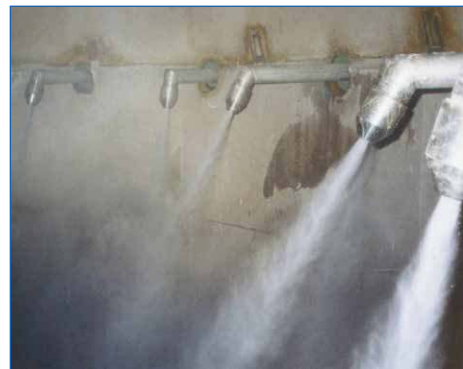
Bild 19: Verdampfungskühler – Innenansicht
