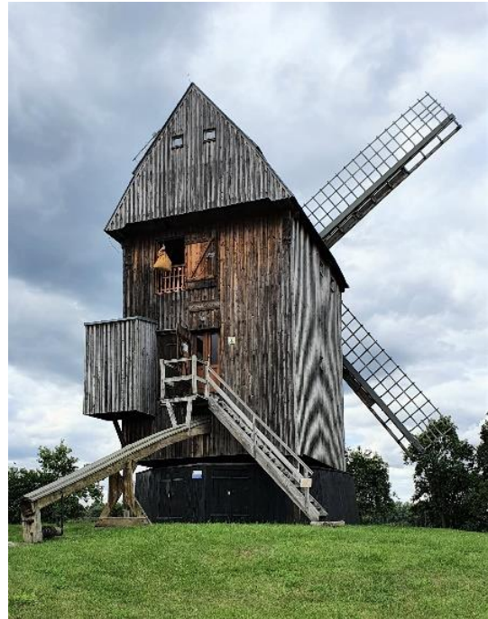
Die Mühle wurde letztmalig 1972 mit dem Steert in den Wind gedreht und danach dauerhaft befestigt. Die Flügel lassen sich aber weiterhin drehen.
