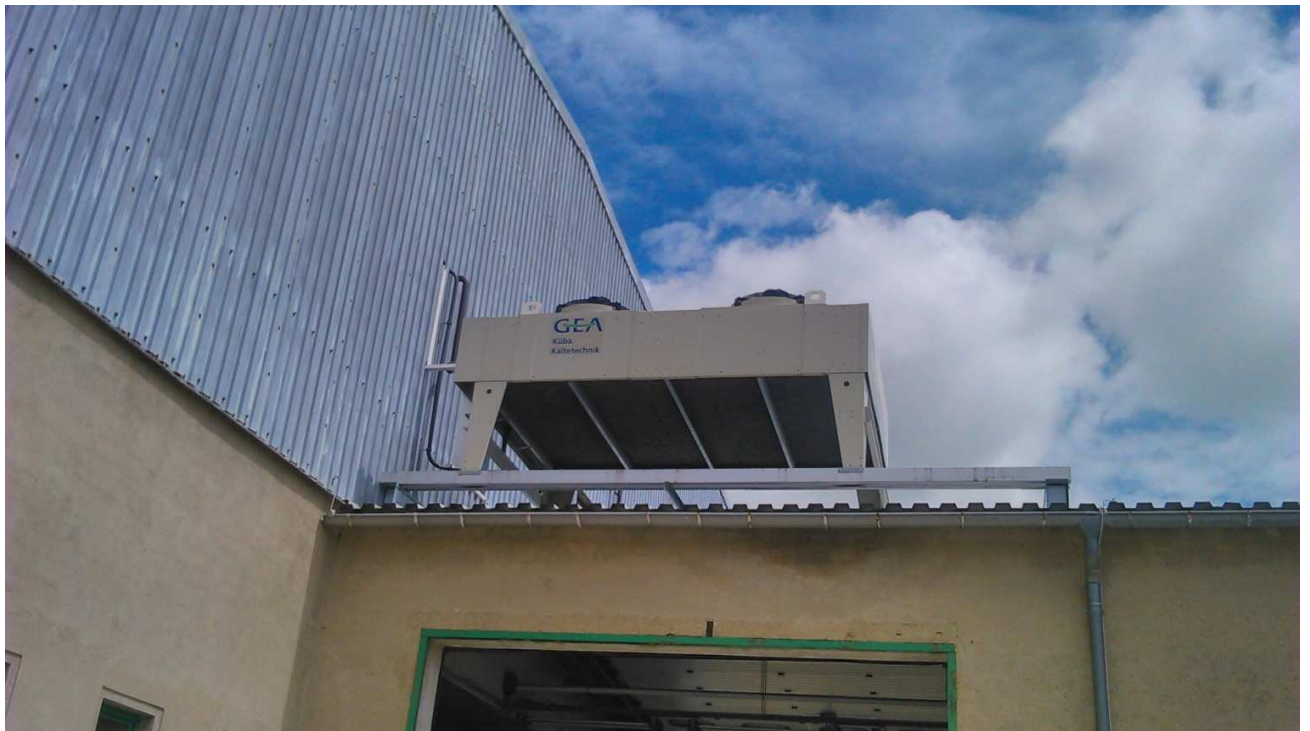
Abbildung: Beispiel Lüftungs- und Klimagerät GEA Küba Verflüssiger (hier: EQ4)
