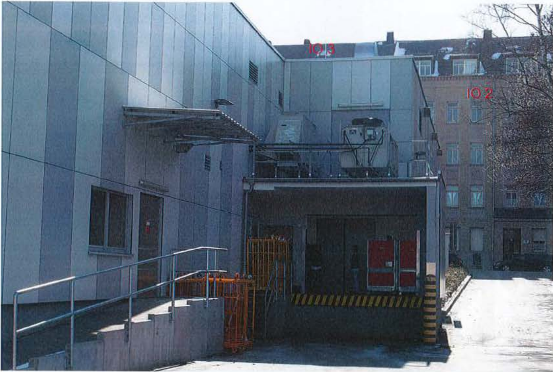
Bild 1 Immissionsorte 2+3, Limbacher Straße und Zufahrt und Rampenbereich
