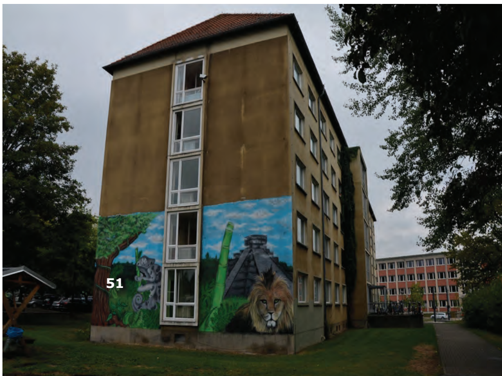
Bild 19: Blick in westliche Richtung zum Gebäude Reichenhainer Straße 51
