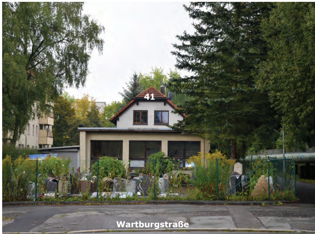
Bild 23: Blick in südöstliche Richtung zum Gebäude Wartburgstraße 41
