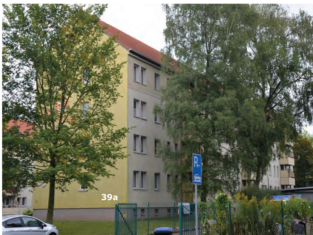
Bild 22: Blick in südöstliche Richtung zum Gebäude Wartburgstraße 39a
