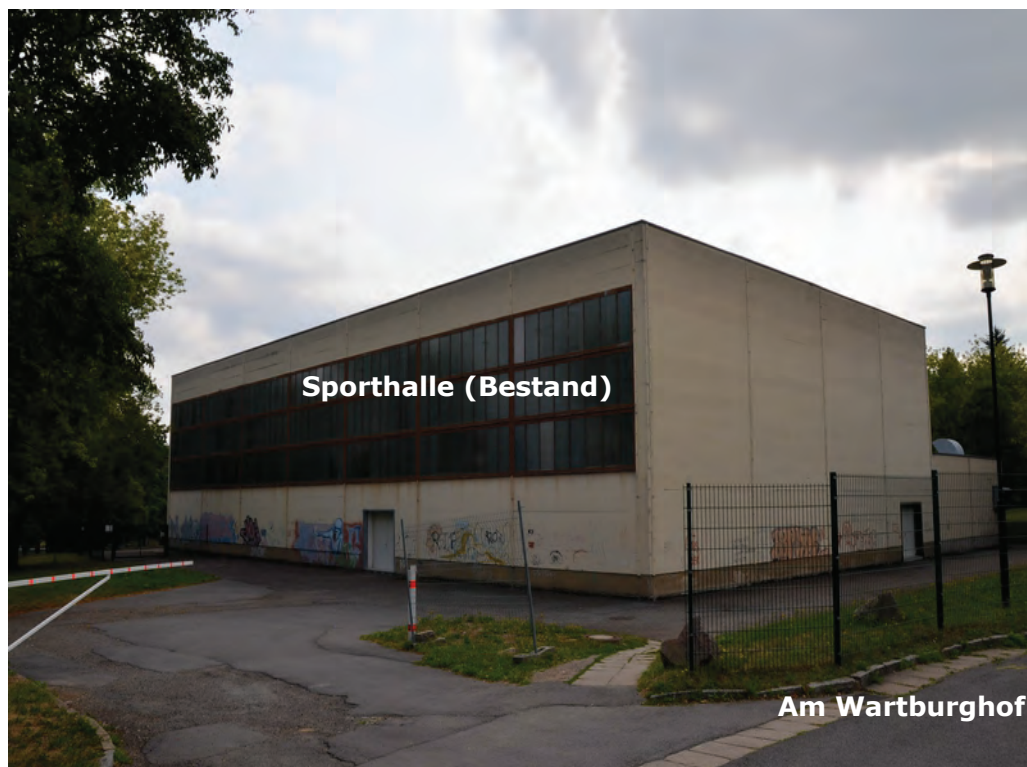
Bild 13: Blick von der Straße 'Am Wartburghof' in östliche Richtung zur bestehenden Sporthalle (Abbruch nach Errichtung der neuen Sporthalle)
