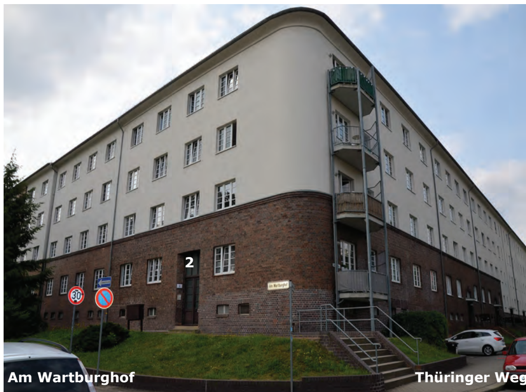
Bild 10: Blick in südliche Richtung zum Wohnhaus Am Wartburghof 2
