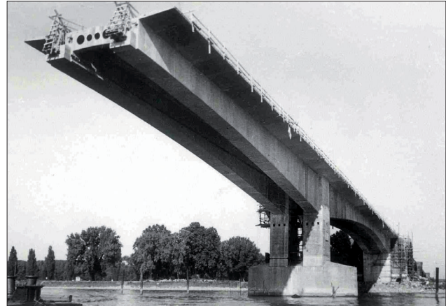
Abb. 4: Bau der Rheinbrücke Worms
