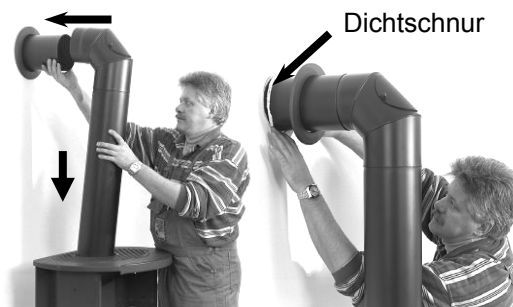
Abb. 5: Montage Rauchrohr
