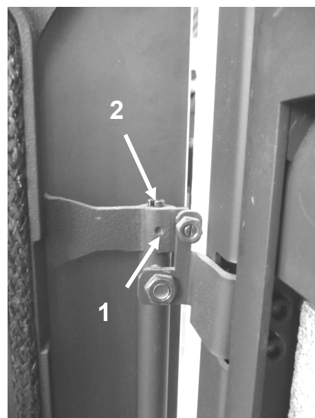
Abb. 15: Türfederspannung nachstellen
