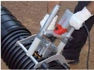
AquaDock-Set bestehend aus nachträglichem Anschluss und Profildichtring DN 150. Der 90°-Anschluss ist sowohl bei Neuinstallation als auch bei bestehenden Rohrleitungen möglich.
