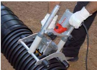
RobuDock-Set bestehend aus nachträglichem Anschluss und Profildichtring DN 150. Der 90°-Anschluss ist sowohl bei Neuinstallation als auch bei bestehenden Rohrleitungen möglich.
