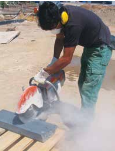
Staubbelastung beim Trockenschneiden
