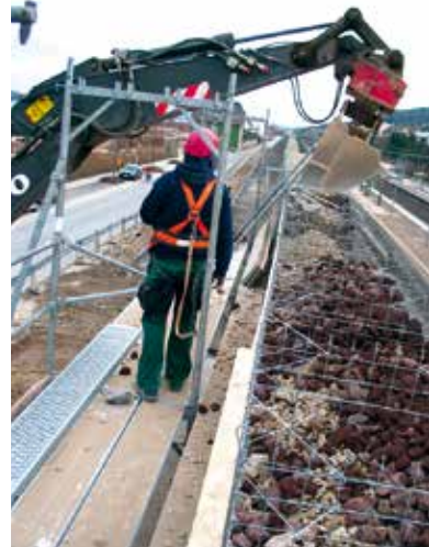
Einsatz von PSAgA auf Arbeitsgerüst vor Gabionenwand bei geöffnetem, dreiteiligem Seitenschutz. Als zugelassener Anschlagpunkt kann der Gerüststrahnen verwendet werden (siehe Aufbau- und Verwendungsanleitung des Herstellers).
