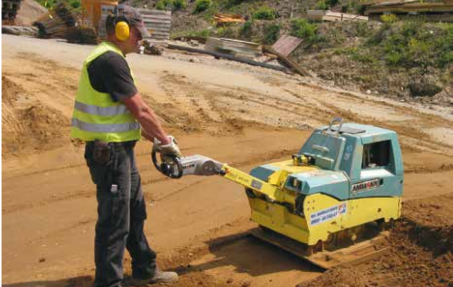
Sicheres Arbeiten mit der Rüttelplatte
