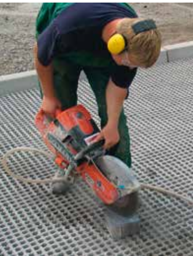
Motortrennschleifer mit Wasseranschluss reduziert die Staubbelastung
