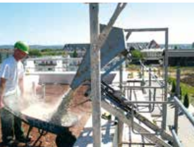
Dreiteiliger Seitenschutz auf Gabionenbauwerk bei Absturzhöhe > 2 m
