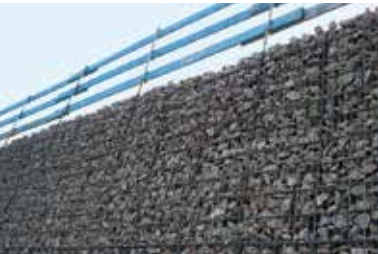
Dreiteiliger Seitenschutz auf Gabionenbauwerk bei Absturzhöhe > 2 m
