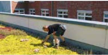
Mauer als ortsfeste Absturzsicherung
