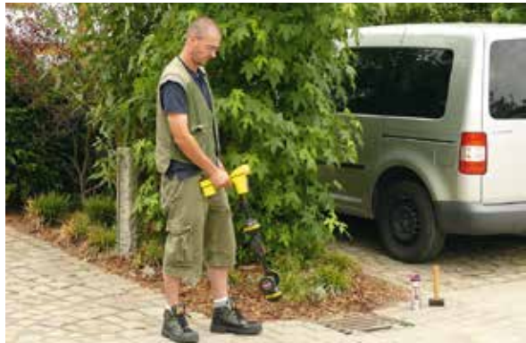
Ortungsgeräte erleichtern das Auffinden von Erdkabeln
