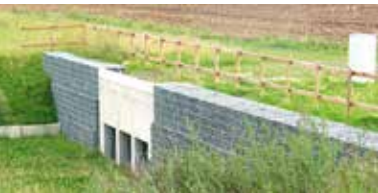
Dauerhaft vorhandene Geländer oberhalb eines Gabionenbauwerks
