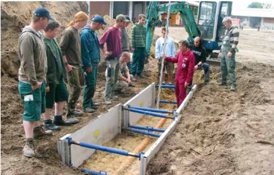
Praktische Ausbildung zum Grabenverbau (Leichtverbau)
