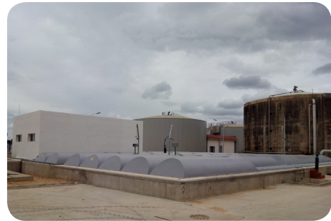
Beispiel: Kläranlage Badajoz / ES mit einem BIOMOX®-CFR
