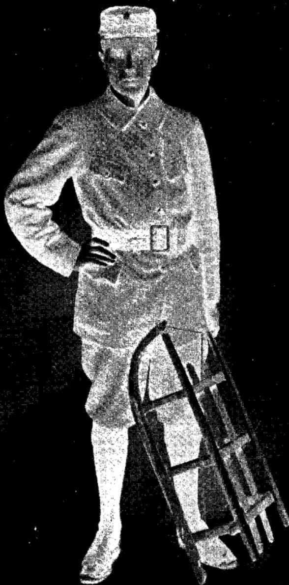
Unterexponierte Platte, durch Hervorrufen mit stark alkalischem Entwickler bei Zusetzen von Bromkalium zu einem brauchbaren Negativ entwickelt.
