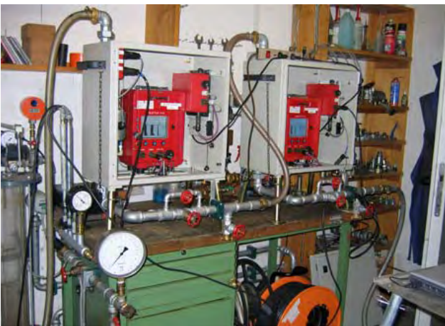
Druck-/Mengenmessgeräte Injektlim/Lugeonlim 4G im Dauertest
