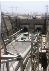
Metro Doha, Crosspassage
