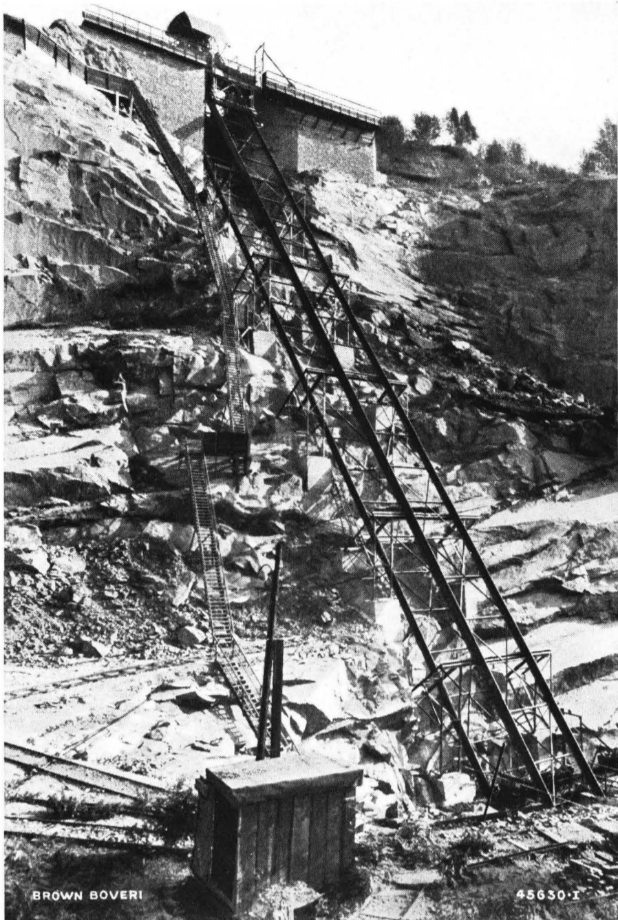
Abb. 51. — Schrägaufzug für automatischen Betrieb in einem Steinbruch, Nutzlast ca. 3000 kg.
