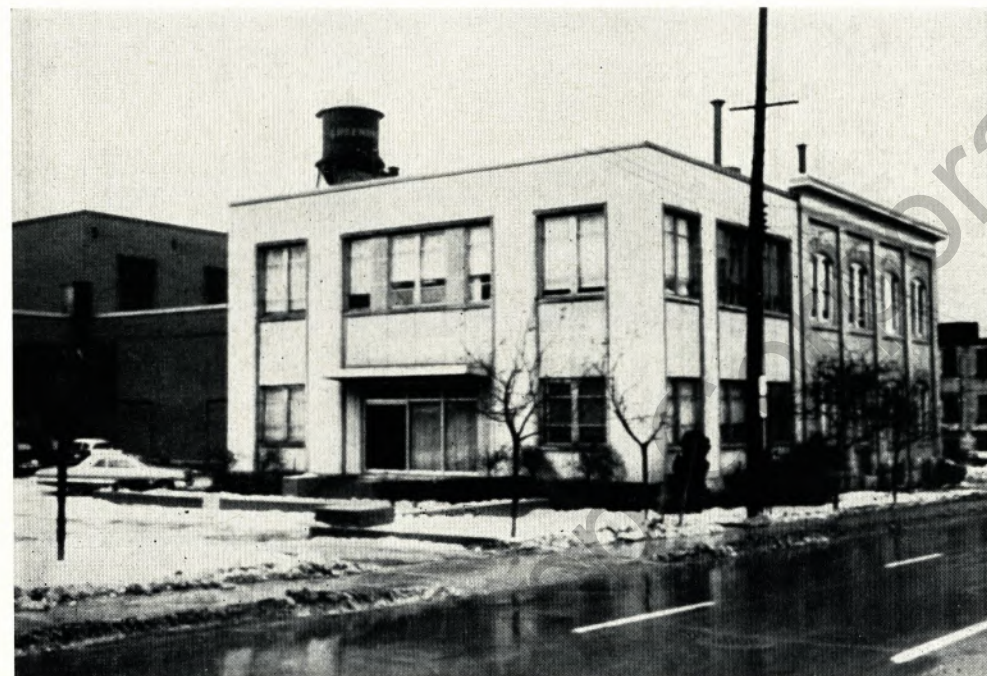
Ein Bürogebäude bei Greening, in dem die jungen Unlöhner manches Neue oder Ungewohnte kennenlernten.
