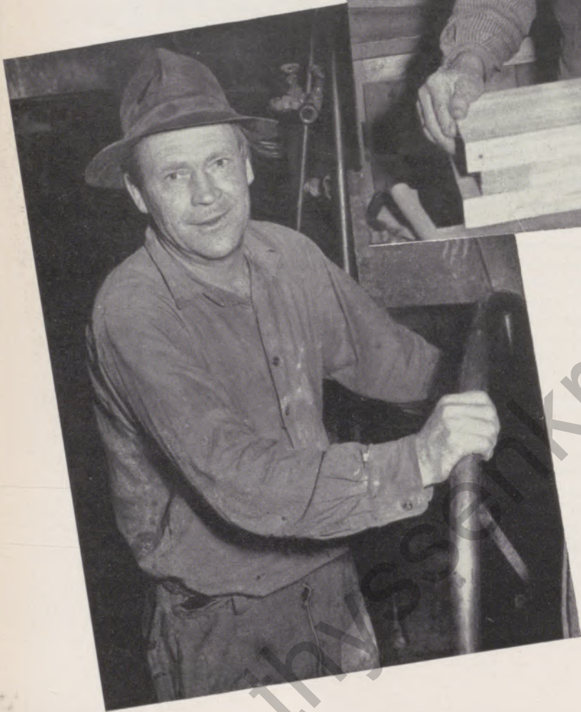
Wilhelm Weidner Ofenmann in der Gießerei Papenberg, bedient die Gieß- trommel, die das flüssige Eisen aus dem kippbaren Vorherd des Kupolofens über- nimmt und dem Drehofen zur Fertig- schmelze zuführt.
