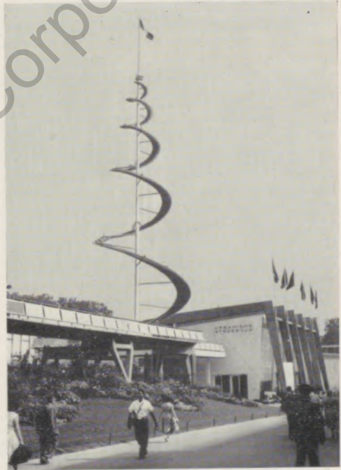
Moderne Bauweise, Halle an Trägern aufgehängt
