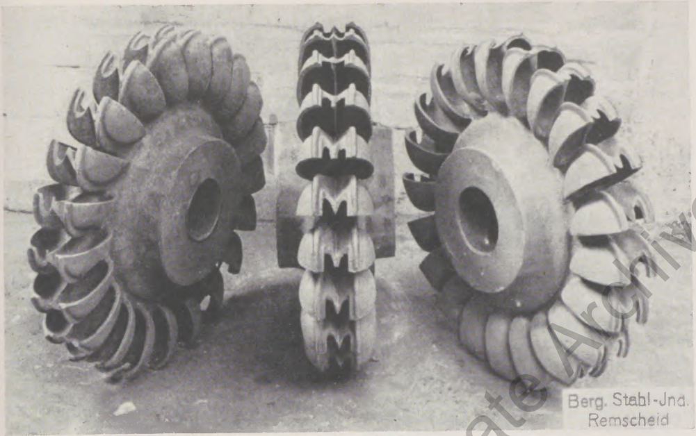
Peltonräder ca. 4000 kg Stückgewicht
