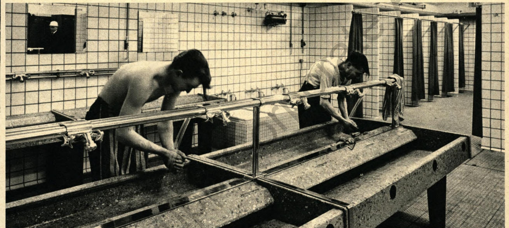
▲ Handwaschbecken und Duschkabinen laden zum Waschen ein
