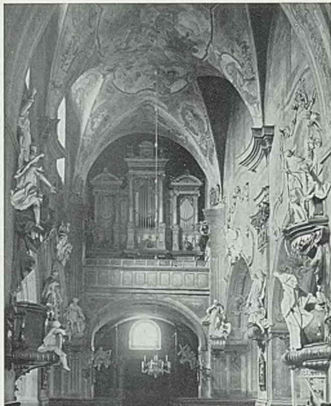
150 OBERGLOGAU - KATHOLISCHE PFARRKIRCHE, ORGELCHOR VOR DEM UMBAU
