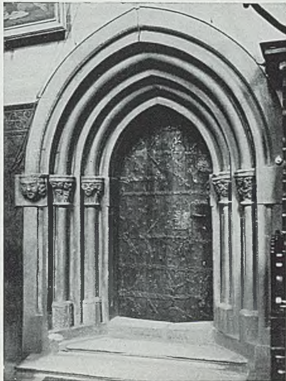
55 GROTTKAU, SAKRISTEIPORTAL DER KATHOLISCHEN PFARRKIRCHE
