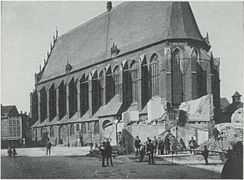
61 ST. JAKOBUSKIRCHE 1888, IM VORDERGRUND ABBRUCH DER ALTARISTENHÄUSER
