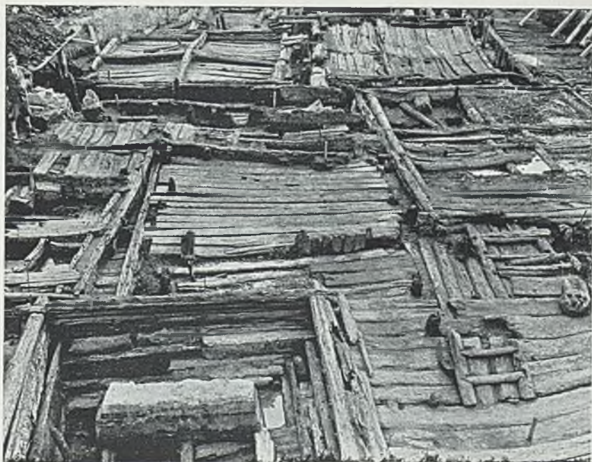
87 GEDIELTE HÄUSER UND STRASSEN
