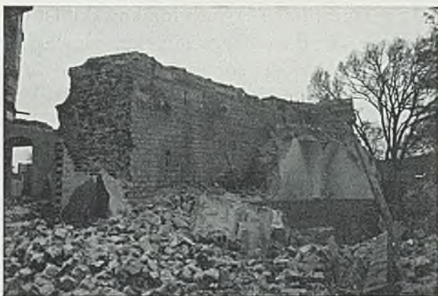
75 FREIGELEGTER TEIL DER BURGMAUER VON 1228 VOR DEM SCHLOSSTURM
