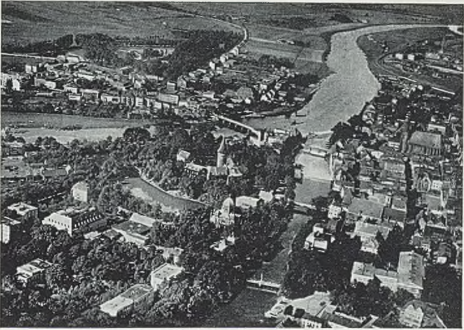
84 FLUGBILD DER OPPELNER SCHLOSSINSEL VOR DEM ABBRUCH DES PIASTENSCHLOSSES 1928
