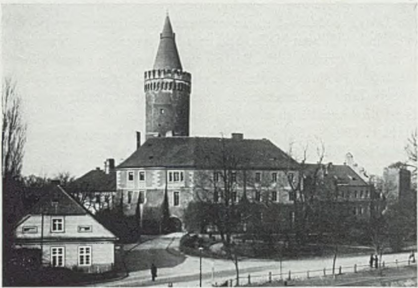
82 DAS OPPELNER PIASTENSCHLOSS 1890 NACH DEM ZWEITEN TURMUBAU
