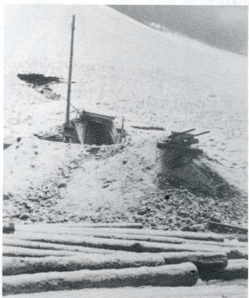
Luftschutzstollenbau am Haag
