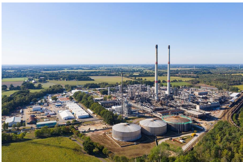
Abbildung 1: Die Erdgasaufbereitungsanlage in Großenkneten
