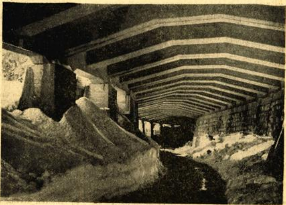
Lawinenschutzbauten auf der Flegelstraße
