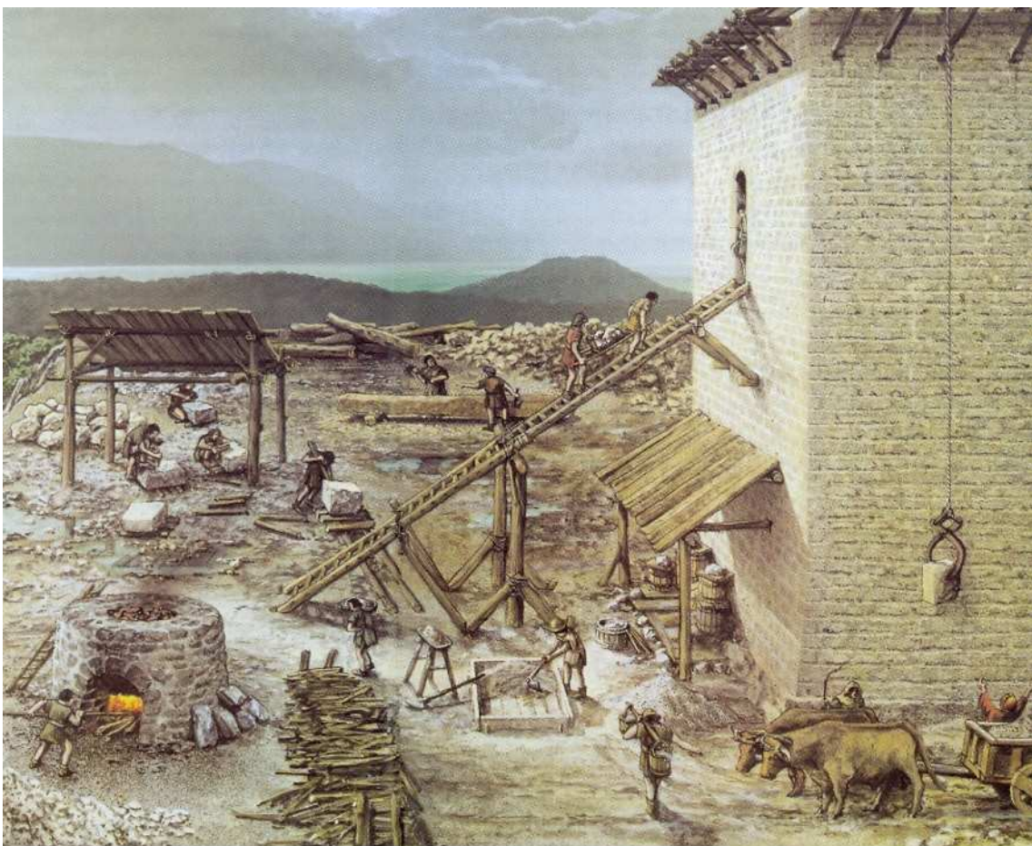
Burgbaustelle um 1220 mit Steinmetzen, Zimmerleuten, Kalkofen und Mörtelkasten. Die Fässer mit ungelöschtem Kalk werden unter einem Dach gelagert. Mörtel und kleines Steinmaterial werden über die Schräge nach oben getragen, die schweren Steine hievt ein Kran mit Hebezange hoch. Die Maurer arbeiten auf dem Auslegergerüst. Bild aus Heinrich Boxler, Jürg Müller, Burgenland Schweiz (Solothurn: Verlag Aare 1991)
