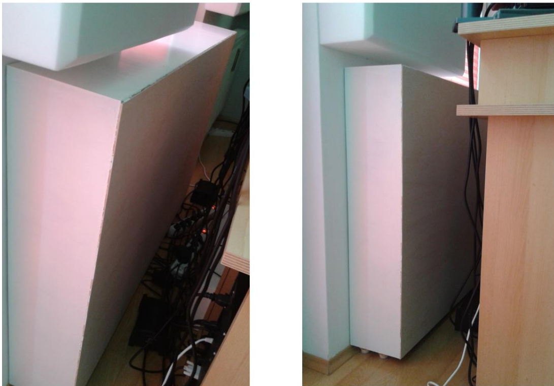
Abb. 2.8: Plattenresonator zwischen Frontwand und Studiotisch (1)
