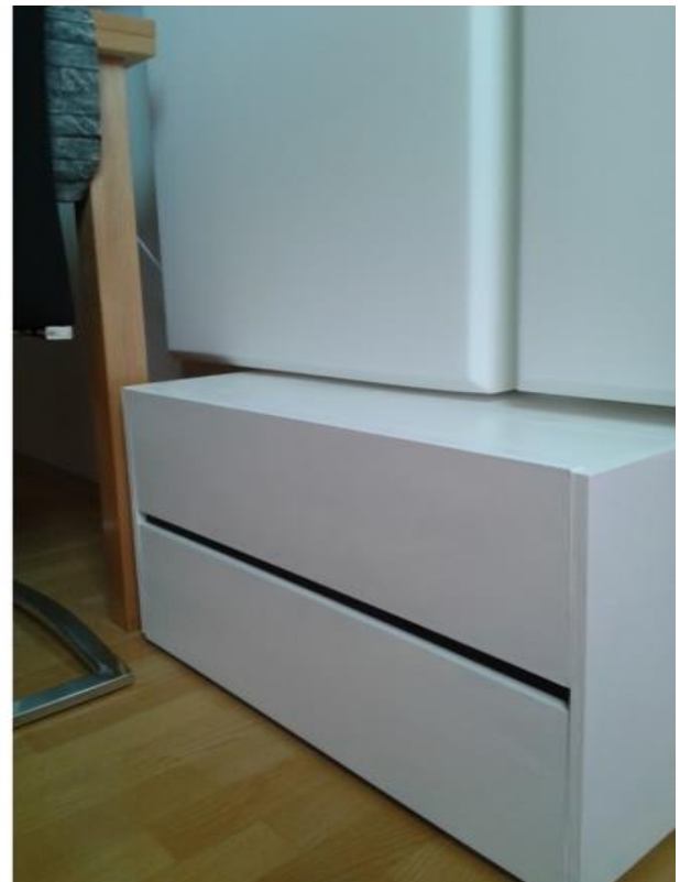
Abb. 2.12: Einzelschlitzresonator unter Keyboard (3) und hinter Esstisch (4)
