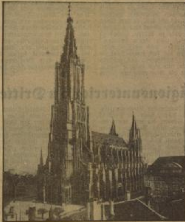
Am Hauptturm des berühmten Ulmer Münsters, der mit seinen 162 Metern der höchste Kirchturm der Erde ist, hat man seit einiger Zeit Bewegungen festgestellt. Um sie zum Stillstand zu bringen und das herrliche Bauwerk unbedingt zu sichern, sollen die Fundamente durch Zuganker befestigt werden.
