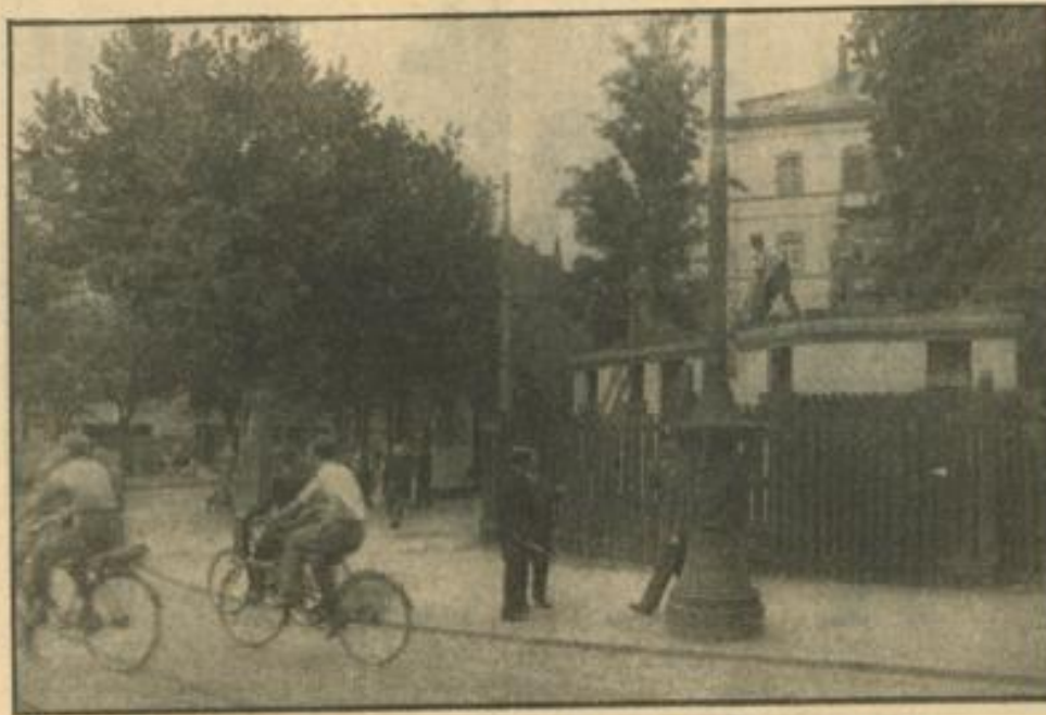
Freie Bahn für die Zufahrtsstraße zum Reichsautobahnweg Aufnahme: Franck Abbrucharbeiten an der Ecke Heidelberger Straße / Friedrichstraße HB-Bildstock
