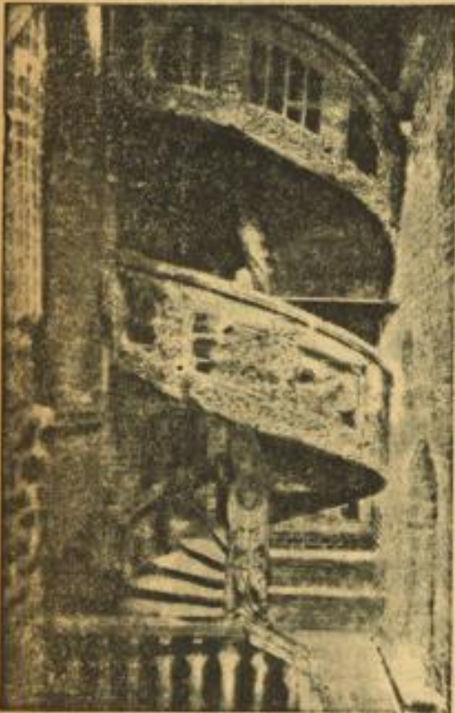
Reich verzierter Treppenaufgang im Hochschloß
