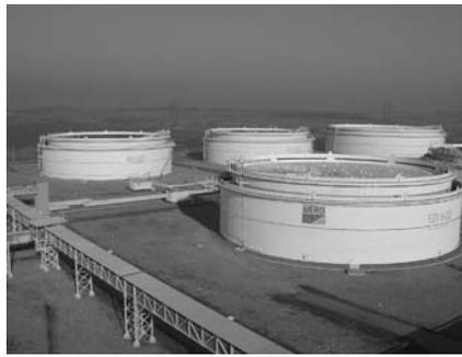
(15) Tankbehälter zur Zwischenlagerung von Rohöl.
