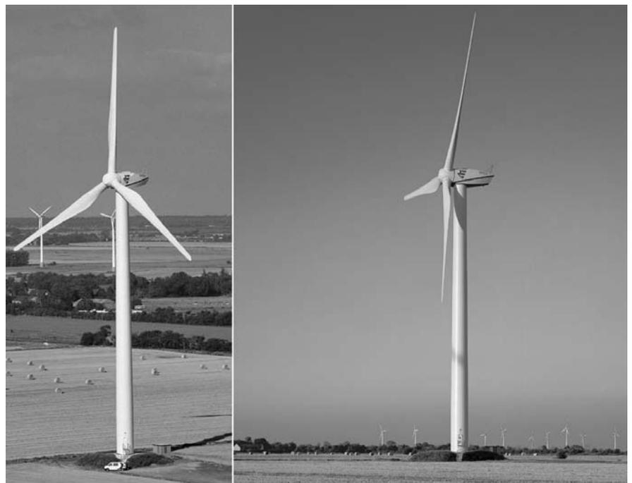
(18) Windenergieanlagen auf stählernen Rohrtürmen.
