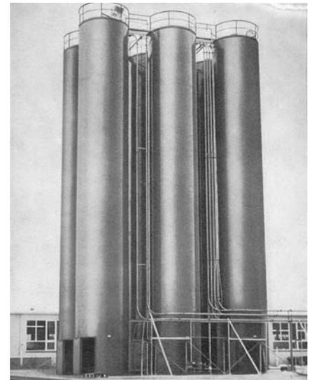
(7) Silogruppe aus Stahl zur Speicherung von Kunststoffgranulaten.
