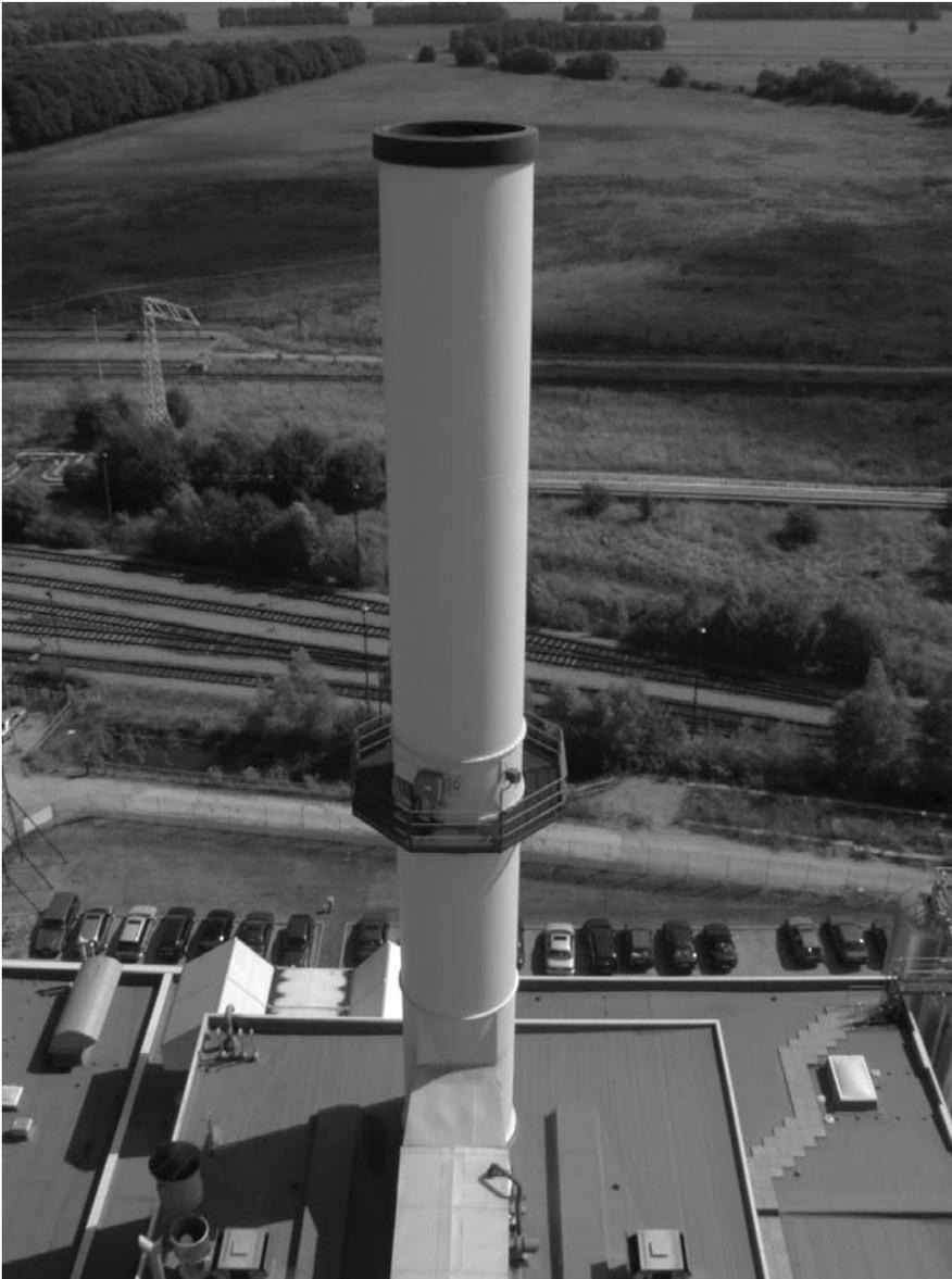
(10) Doppelmantelschornstein eines Heizkraftwerkes.
