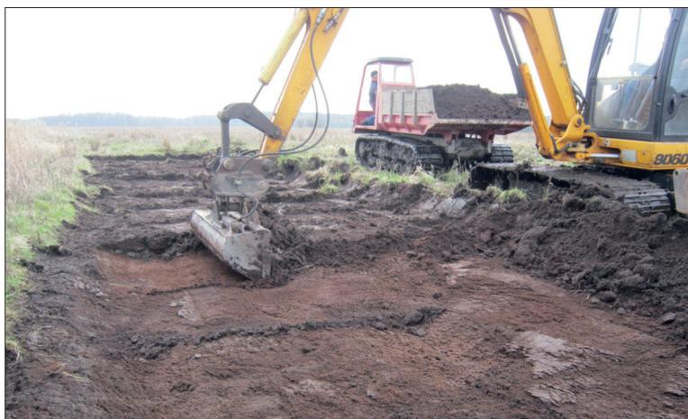
Abb. 12: Umsetzung: Stufe 1 abgetragene Grasnarbe im Hintergrund, Stufe 2 Abtrag des Oberbodens im Vordergrund; die Maschinen fahren immer auf der tragfähigen Grasnarbe (April 2014, M. Pfeiffenberger)
