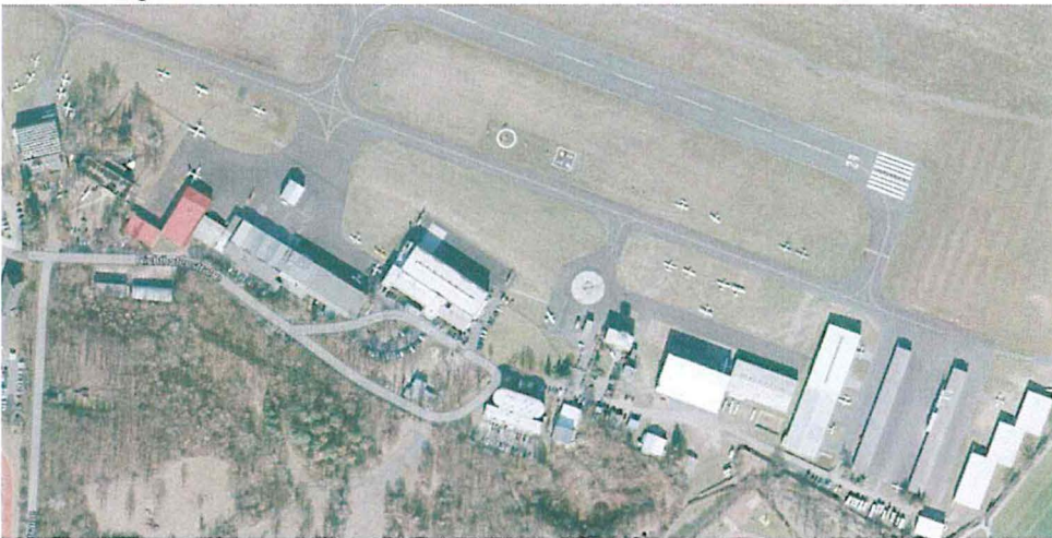
Abbildung 15: Orthofoto EDKB – Hangar Air Alliance
