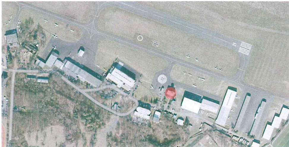
Abbildung 2.: Orthofoto EDKB – Verwaltungsgebäude
