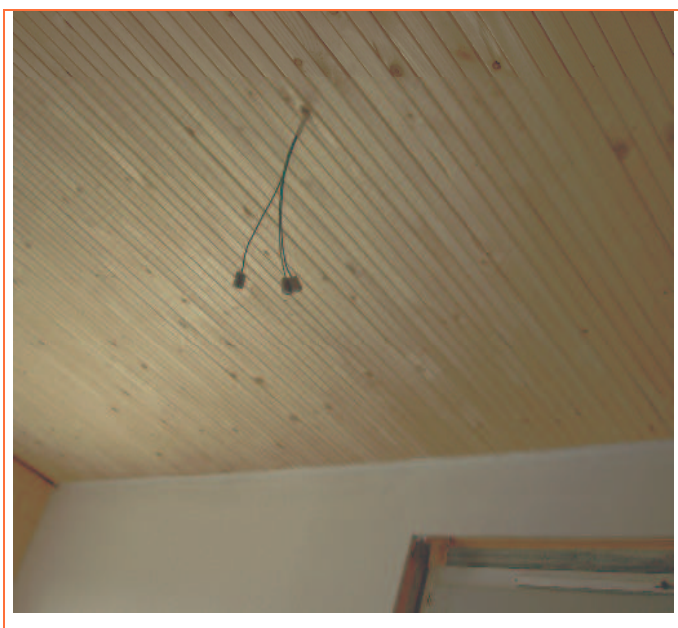
Abbildung 4-39: Anschluss Deckenleuchte bei sichtbarer Brettstapel-Decke
