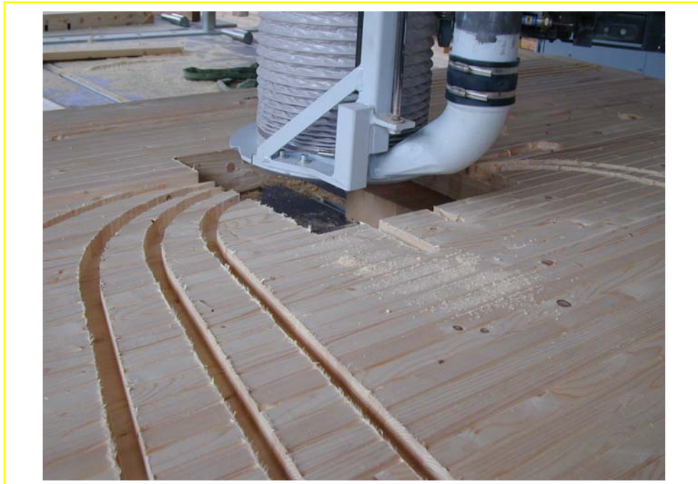
Abbildung 7-4: einfräsen von Leitungskanälen
