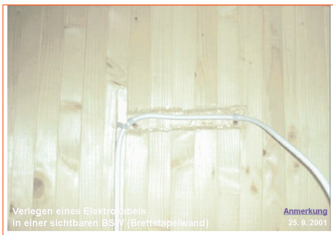
Elektro-Kabel in sichtbarer Brettstapelwand
