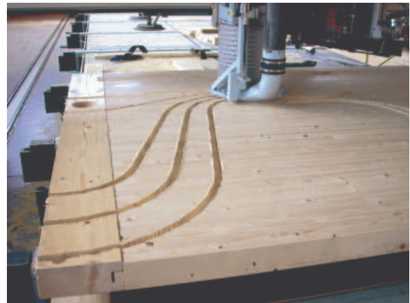
Fräsung der Leitungsquerschnitte mit Multifunktionsbrücke
