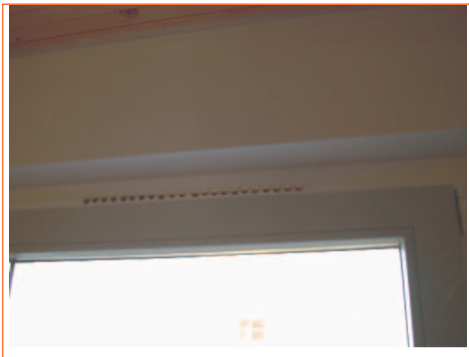
Abbildung 4-40: Zuluftbohrungen für Ventil im oberen Fensterblendrahmen
