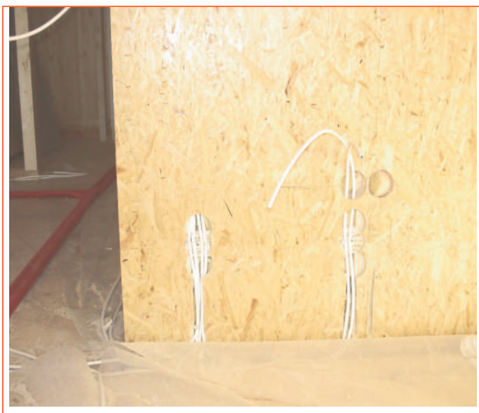
Abbildung 4-38: Leitungsführung (Heizung und Elektro/Kommunikation)
