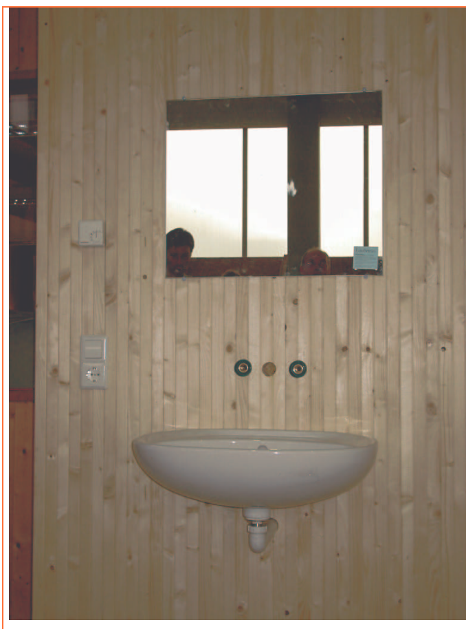
Abbildung 4-8: Designstudie: Medienkanal auf sichtbarer Brettstapel-Wand
