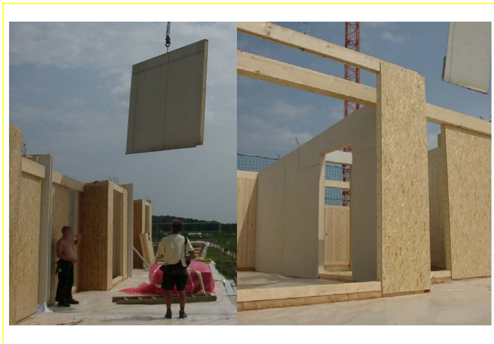
Abbildung 8-4: Montage von Brettstapelwänden
