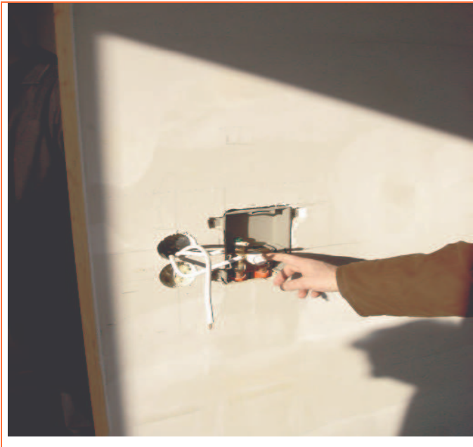
Unterputz-Thermostatkopf für Wandheizfläche
