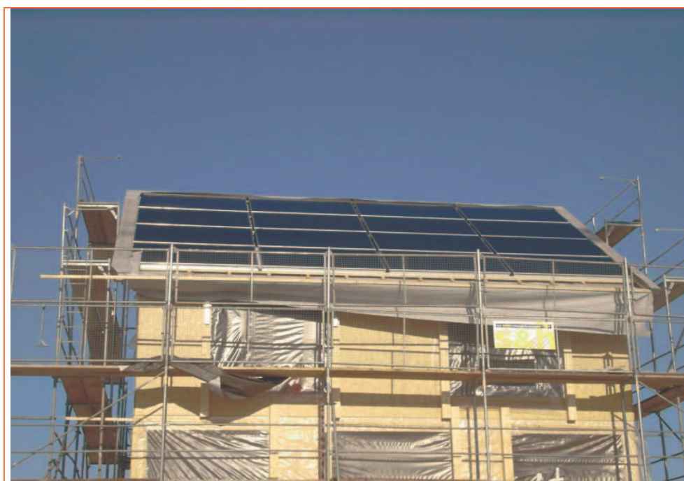
Abbildung 4-42: Solar-Synergie-Dach, ohne Zwischenbleche und Randeinfassung
