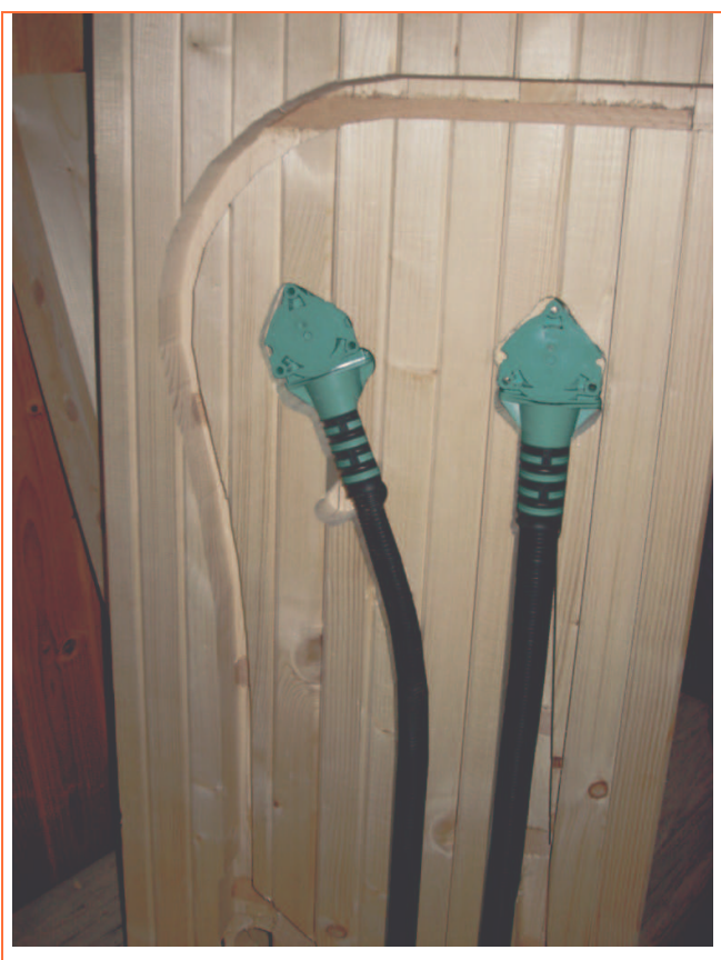
Abbildung 4-13: Anschlussdosen eingefräst in Brettstapel
