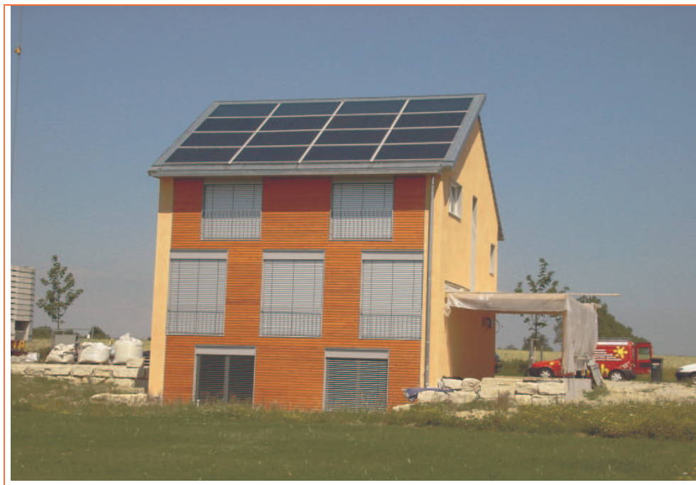
Abbildung 4-41: Südansicht Wohnhaus Klute, kurz vor Fertigstellung
