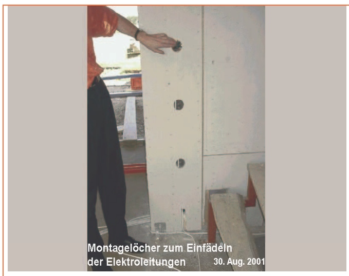
Montagelöcher zum Einfädeln der Elektroleitungen
