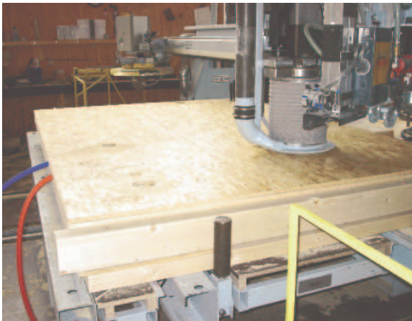
Die mit Installationen bestückte Seite des Elements wird mit OSB-Platten beplankt, hierin werden weitere notwendige Bohrungen und Fräsungen angebracht
