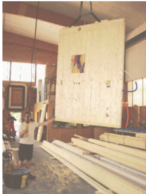
Das bestückte und beplankte Wandelement wird vom Bearbeitungszentrum zur Endmontage transportiert
