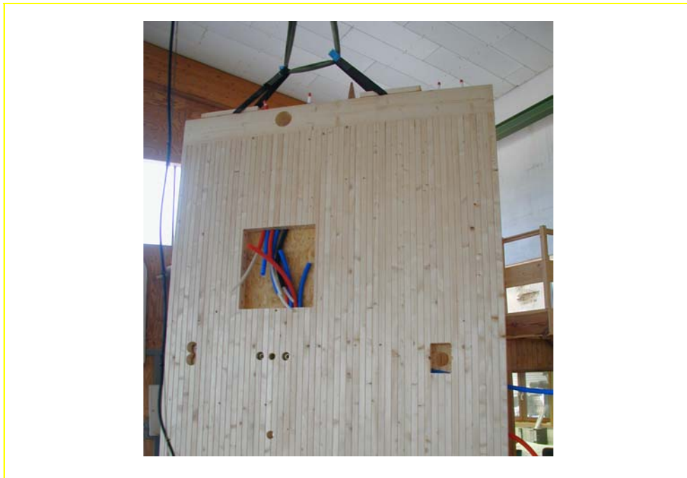
Abbildung 7-7: Rück- Sichtseite eines komplett bekleideten Elementes
