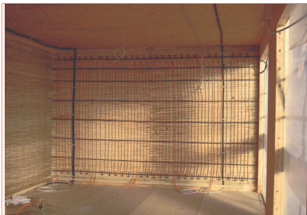
Abbildung 4-45: Kunststoff-Wandheizflächen Register im Rohbau
