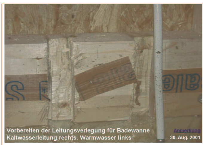
Vorbereitete Leitungsverlegung Kalt- und Warmwasser
