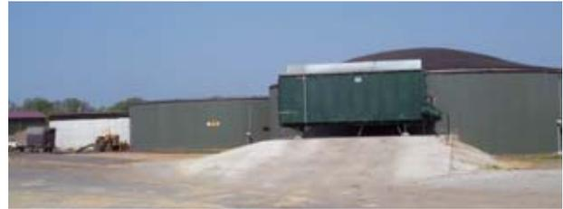
Abb. 5-11: BGA 15; Feststoffbesickerer; dahinter Fermenter, daneben Nachgärer und Gärückstandslager (v.r.n.l.)
