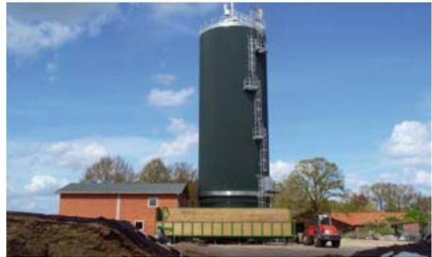
Abb. 5-37: BGA 49; Feststoffbeschicker; dahinter Fermenter, daneben Betriebsgebäude
