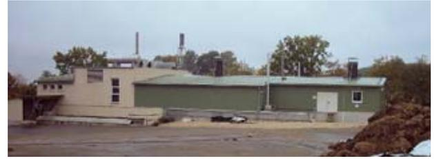
Abb. 5-42: BGA 53; Gebäude für BHKW mit Gasfackel (links), für Gasspeicher (Mitte) und Separator (rechts); Eintragsvorrichtung links (versenkt); Fermenter als Unterbau
