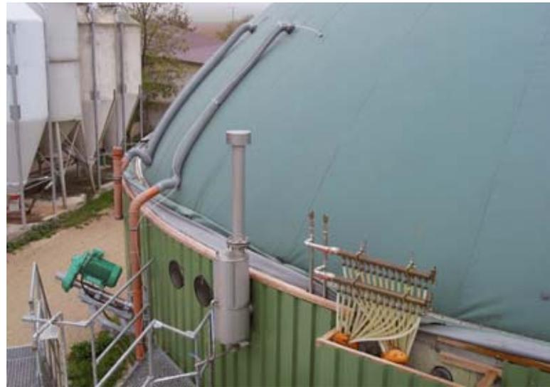
Abb. 5-21: BGA 26; Fermenter mit Gaslager, Rührwerk und Überdrucksicherung
