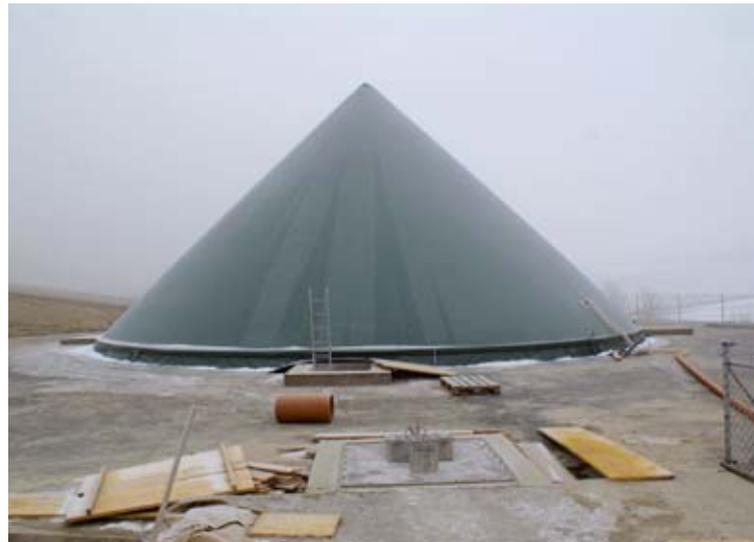
Abb. 5-27: Ring in Ring Gärückstandslager mit integriertem Gasspeicher
