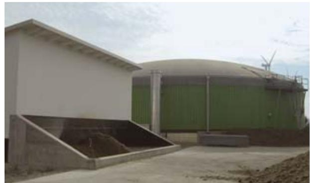
Abb. 5-1: BGA 01; im Vordergrund: Feststoffeinbringung, hinten rechts: Fermenter
