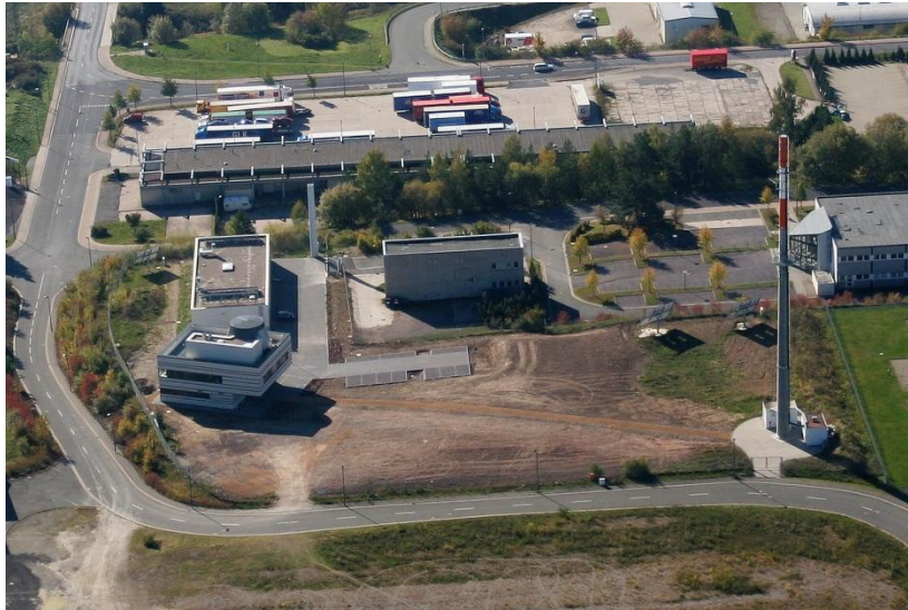
Abbildung 77 Luftbild der Testanlage
