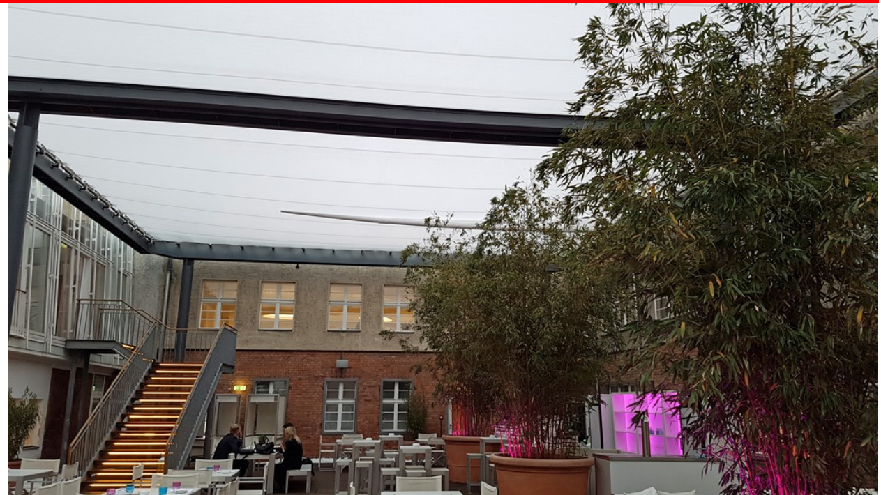
Innenhof, Hotel Ellington, Berlin, Deutschland, Fahrkonstruktion, Steuerung, Stahl und Membran der elnic GmbH
