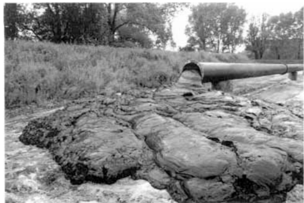
Abb. 6-24 Umlagerung von Baggergut mit Hilfe des MPF-Verfahrens. Der Greifbagger beschickt den Aufgabetrichter in der Bildmitte. Das Baggergut wird durch die Rohrleitung im Vordergrund gefördert; (rechts): mit dem MPF-Verfahren gefördert Sediment auf einem Spülfeld. Das Material besitzt aufgrund des niedrigen Wassergehalts eine sehr hohe Viskosität (Fotos: Möbius GmbH)
