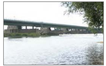
Wehr Geesthacht (Foto: Heise)
