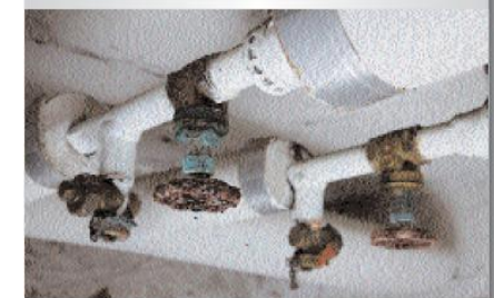
Fehlende Dämmung
