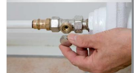
Prüfen der Voreinstellung an einer Rücklaufverschraubung
