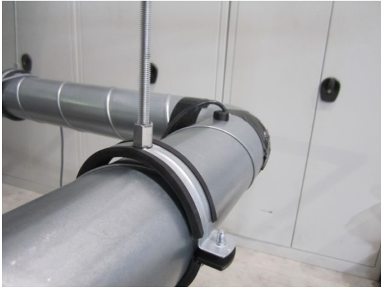
Abbildung 2.26: Komponente Belimo direkt nach Rohrbogen ohne ausreichende Einlaufstrecke mit seitlicher Anströmung
