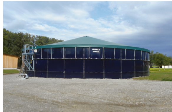
Güllelagerabdeckung mit Zelt Dach (Quelle: H.U. Kohli AG)
