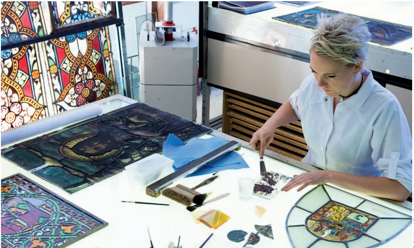
Abbildung 1: Restaurieren von Bleiverglasungen
