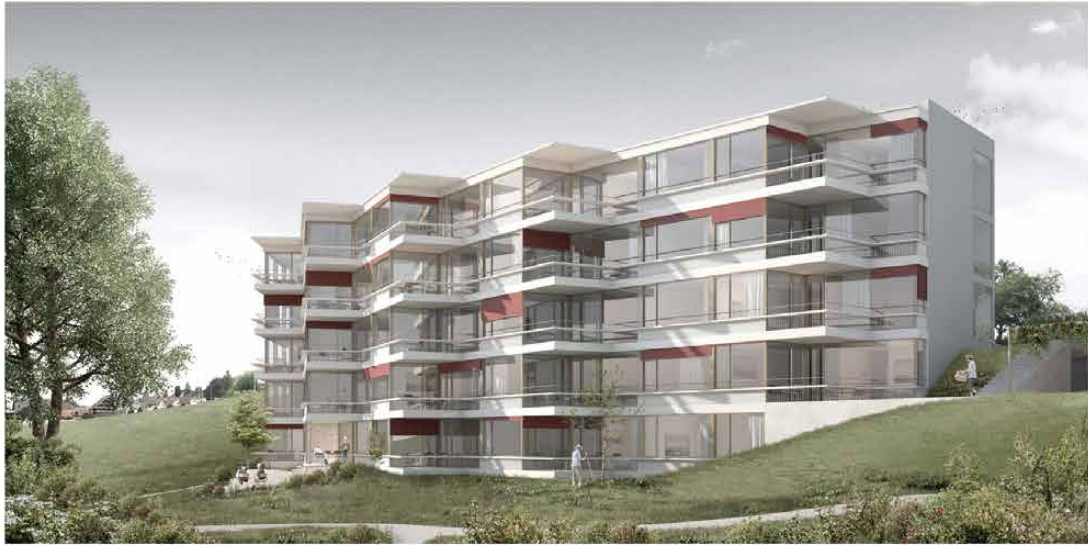
Lady Windermere Seepark Eich - Wohnen im Alter
