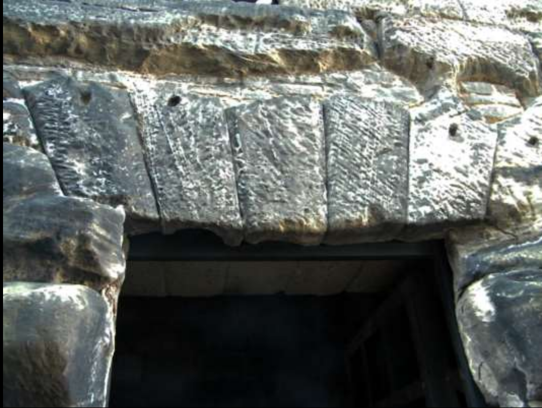
Tragverhalten des Bogens Ein einfaches Anwendungsbeispiel zur Coulomb-Methode: Der scheinrechte Bogen (Platebande)
