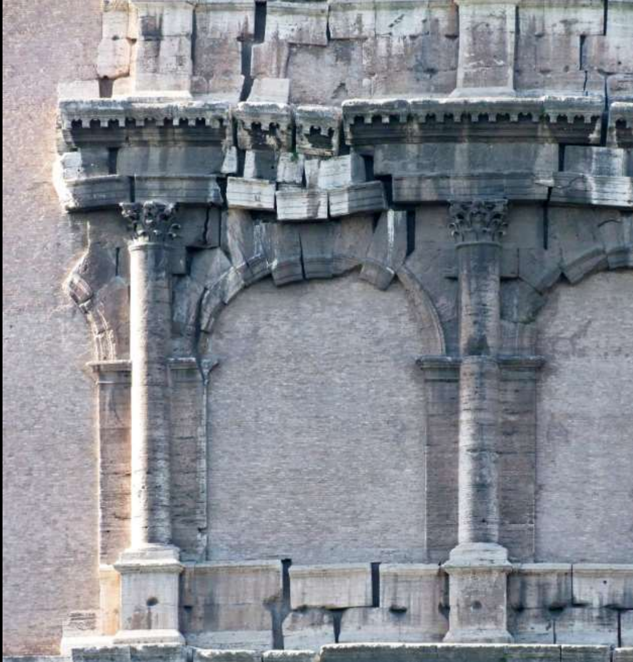
Der Weg zu einer Theorie des Bogens: Beobachtungen am Bauwerk (fast eingestürzter, durch Vermauern gesicherter Bogen am Kolosseum in Rom)
