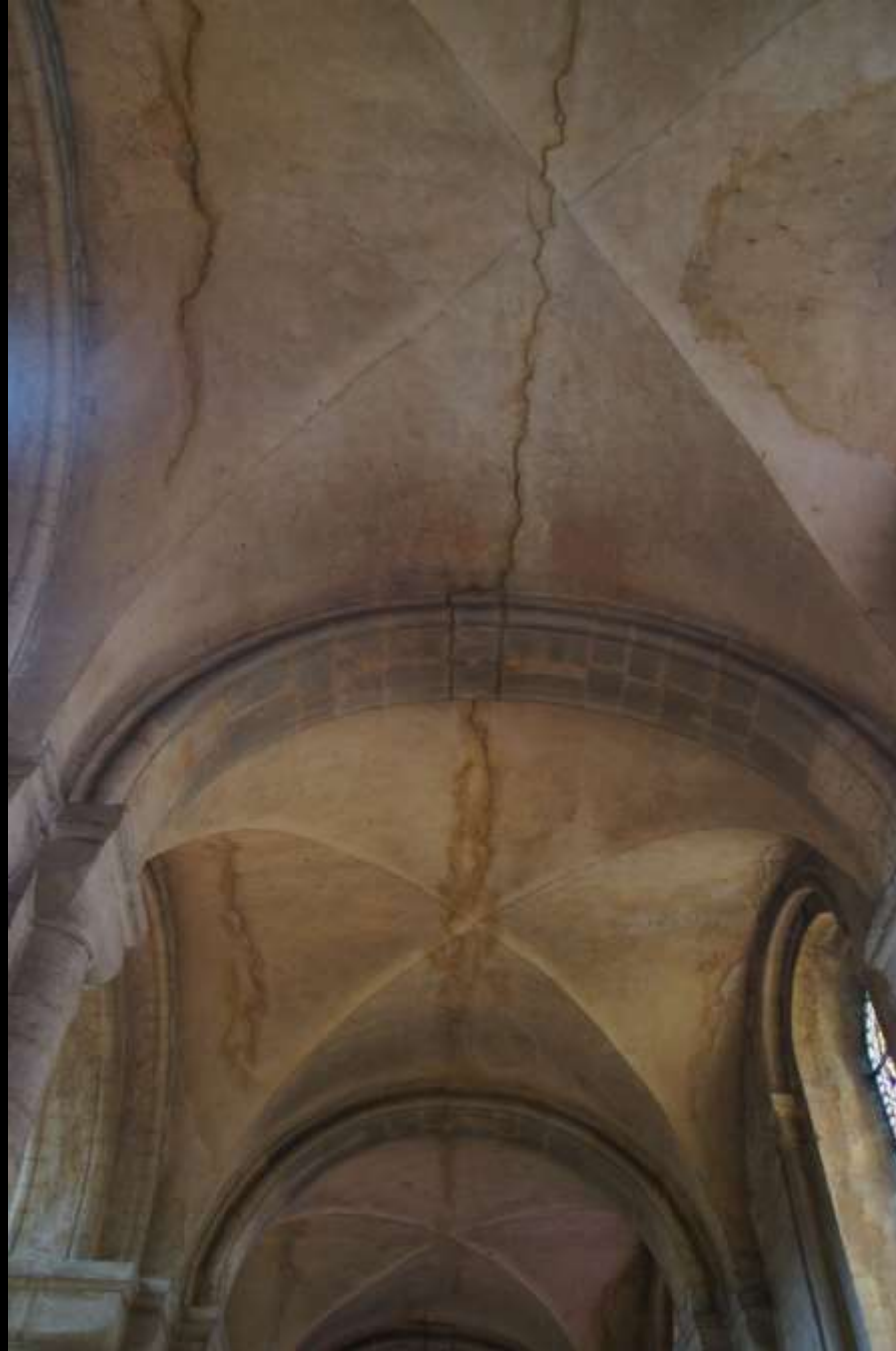
Sabouret-Risse und Scheitelriss in einem romanischen Kreuzgewölbe (Ely, 12. Jh.)
