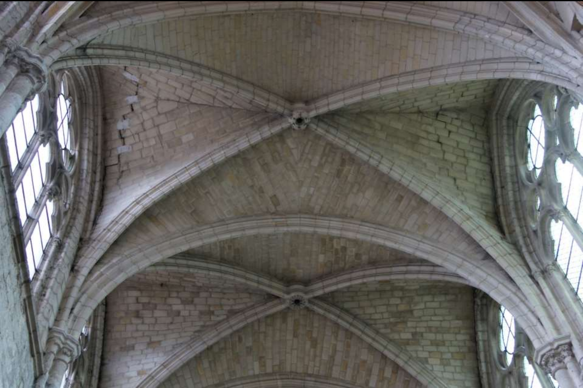
Sabouret-Risse in den Schildkappen eines Kreuzrippengewölbes (Moret-sur-Loing, 13. Jh.)
