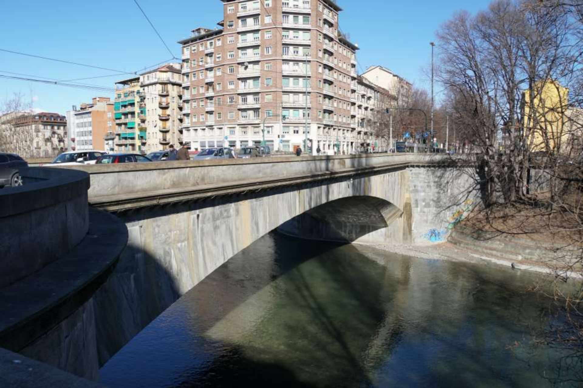
A.P. Castigliano, Théorie de l'équilibre des systèmes élastiques , 1879. Nachrechnung des Ponte Mosca über die Dora Riparia in Turin (1823–30) als elastischer Balken
