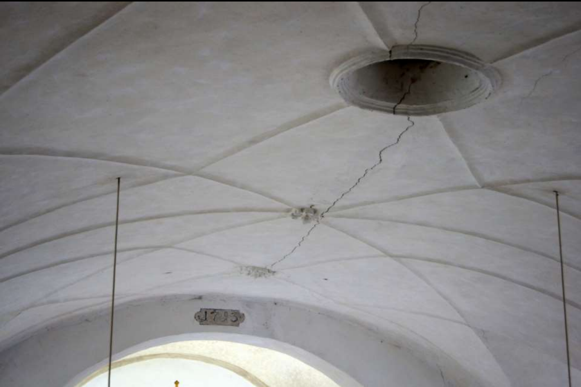
Scheitelriss in einer Stichkappentonne (Kreuz b. Glonn/Oberbayern, 17. Jh.)
