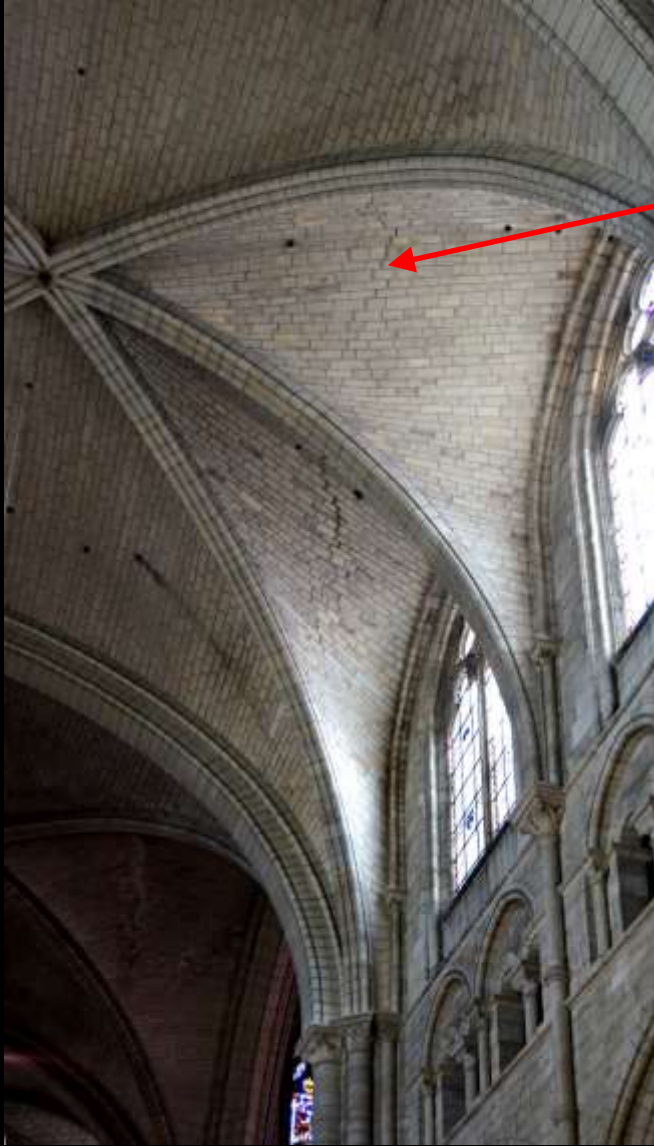
Mechanismus C: Kappe reißt durch (häufigster Mechanismus, "Sabouret")
