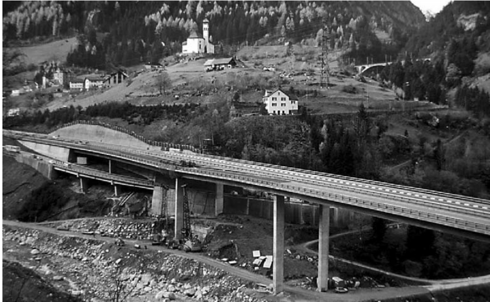
Reussbrücke Wassen – Reparaturarbeiten
