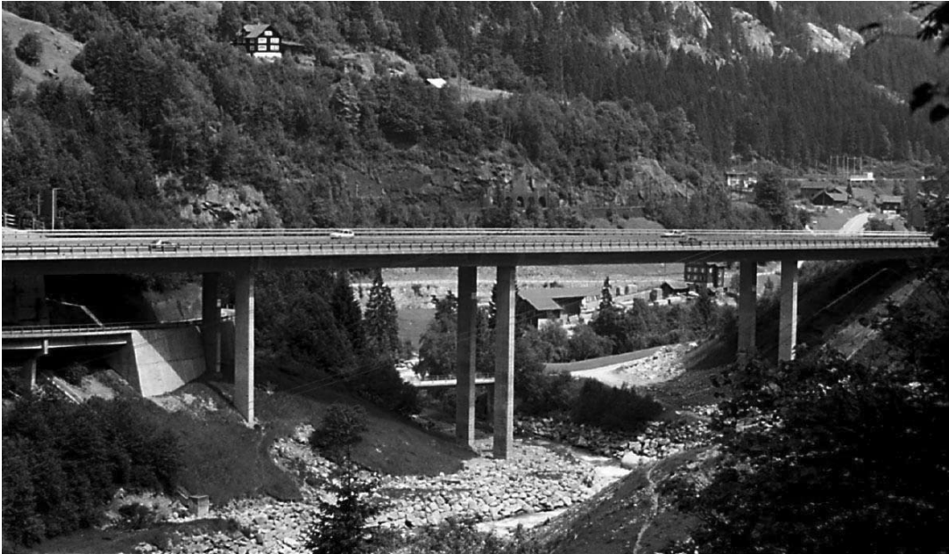
Reussbrücke Wassen (Baujahr 1972) im Juli 1987
