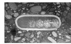
NB. Spannstahl liegt **nicht** zentrisch im Hüllrohr, sondern auf der Krümmungsinnenseite.
