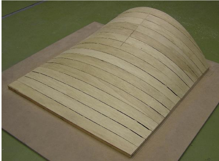
Abb. 5-4 Fertig gebaute Schalung
