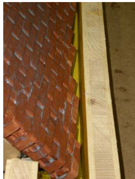
Abb. 5-6 Abschaltung für Vergussmörtel und abgestufte Mauersteine
