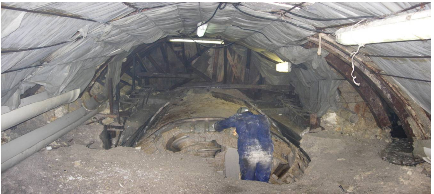
Bild 5: Freigelegter Bohrkopf Tm 7466
