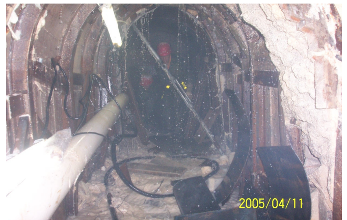
Bild 4: Verhältnisse im Bypass 5
