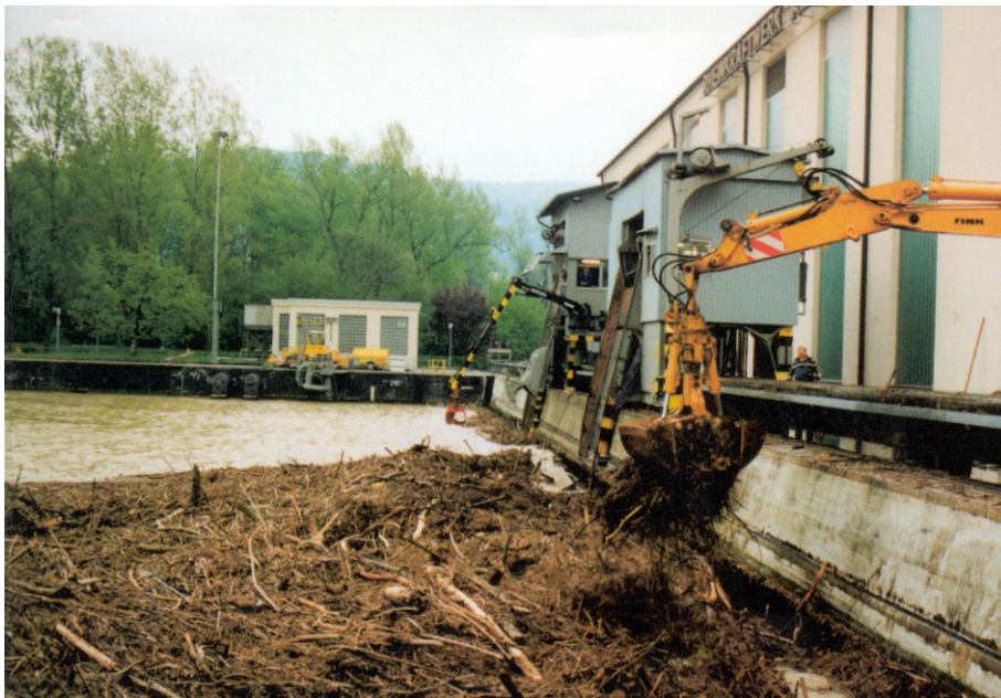
Abb. 2.2: Starker Geschwemmselanfall am Rechen des Rheinkraftwerks Albruck-Dogern beim Maihochwasser 1991. Innerhalb von zwei Tagen fielen insgesamt rund 4000 m 3 Geschwemmsel an, was dem Transportvolumen von ca. 500 Lastwagen entsprechen würde.
