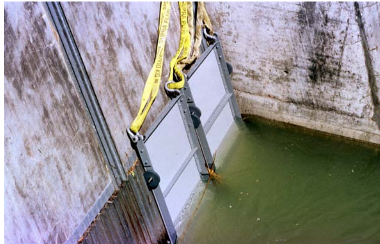
Abb. 6.4: Detailansicht der Verlegung im Rechenfeld 1 für Lastfall 3. Die Räder an den Elementen sichern die Verlegung gegen seitliches verschieben und gewähren eine bessere Montage.
