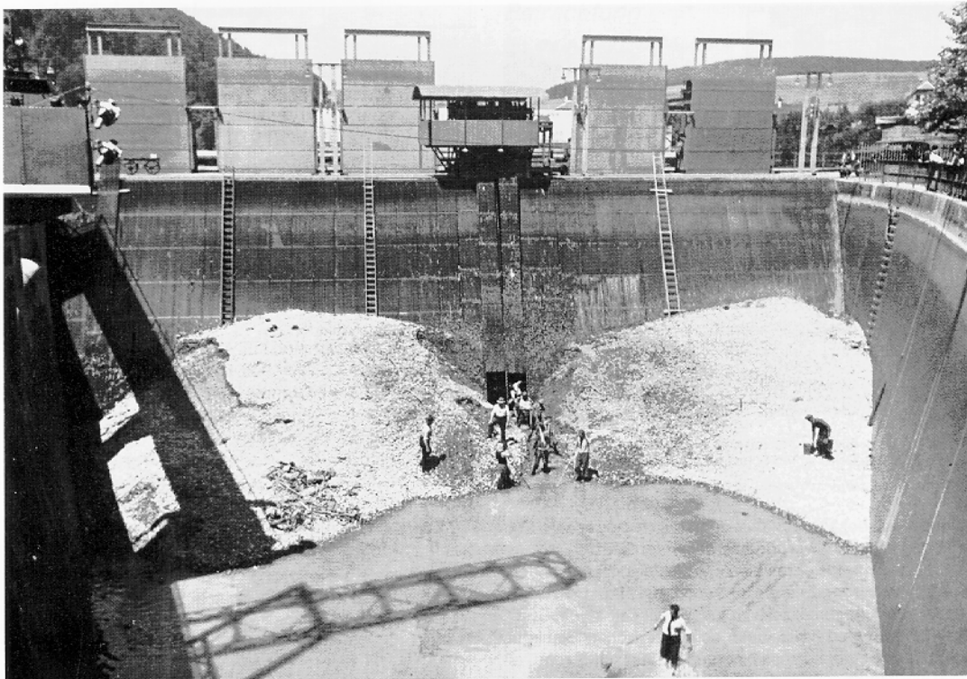
Abb. 2.29: Rechen vor dem Turbineneinlauf des Kraftwerks Felsenau (Elektrizitätswerke der Stadt Bern, Schweiz). Zwischen den beiden Haufen angeschwemmten Gerölls wurde ein Einschnitt ausgeräumt, um das Wasser ableiten zu können. Zustand vor dem Umbau 1978 (aus Kienle , 1989)
