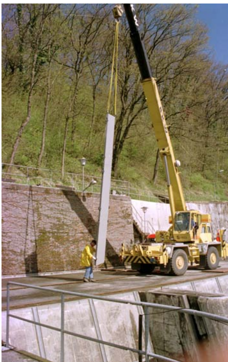
Abb. C.2: Einbau der Verlegungselemente mit einem Mobilkran der BKW FMB Energie AG.
