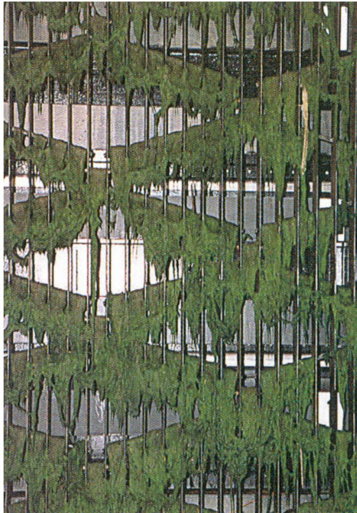
Abb. 2.28: Starke Verlegung des Einlaufrechens mit Wasserpflanzen. Da sich die Wasserpflanzen um die Quertraversen gelegt haben, kann sie nicht von der Rechenreinigungsmaschine und nur im Zuge einer Revision entfernt werden (aus Meier , 2001)
