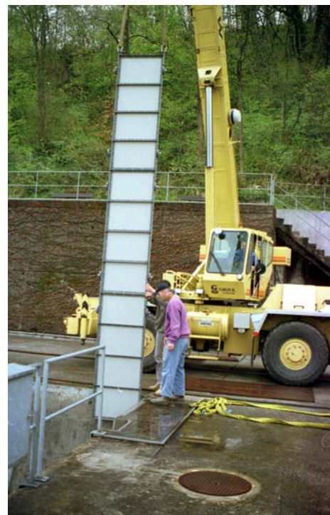
Abb. C.2: Einbau der Verlegungselemente mit einem Mobilkran der BKW FMB Energie AG.
