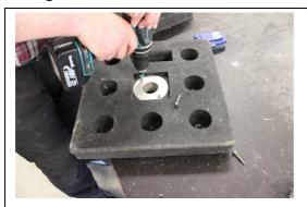
Der Pfostenhalter aus Edelstahl wird mit 2 Stk. TX 25 6x40 befestigt
