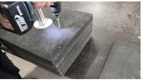
6) Wenn gewünscht können die zwei obersten Platten mit einer Tellerkopfschraube 6x80 verbunden werden, somit ist ein Lösen der Grundplatte nicht möglich.
