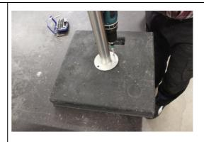
4) Der Absperrpfosten wird mit 2 Stk. TX 25 6x40 montiert
