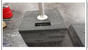
5) Die Platte mit dem Absperrpfosten wird nun auf den Pfostenhalter verbunden
